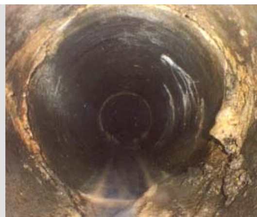
Inkrustation nach erster Reinigung, stellenweise
