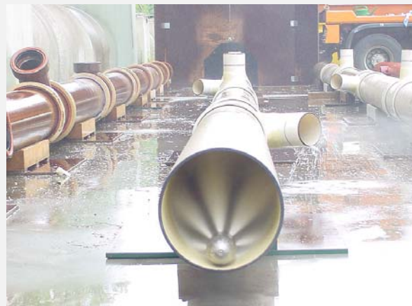
Bild 123: 8-strahlige Düse am Hochpunkt der Haltung
