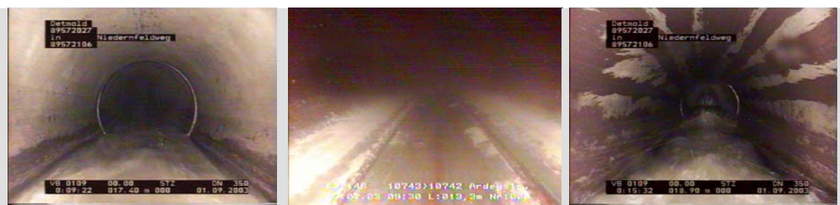
Bild 18: Sichelhaut vor der Reinigung (links), Sichelhautstreifen nach der Reinigung, Bildbeispiele (mitte und rechts)
