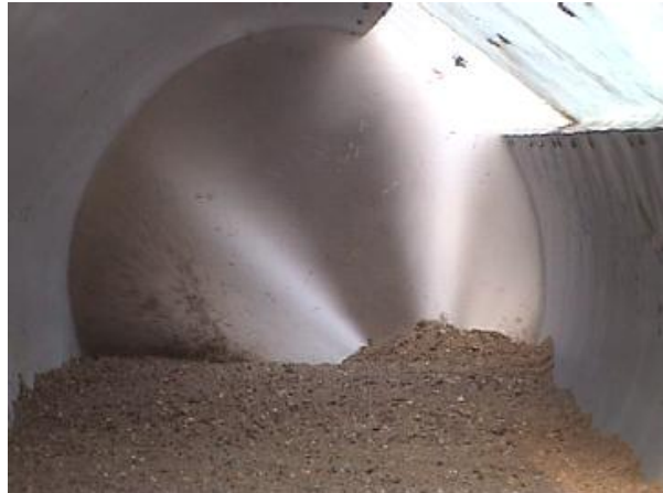
Bild 77: Düse bleibt stecken, DN 800
