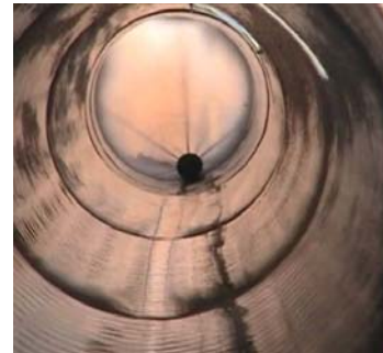
Bild 63: Freigespülte Strecke
