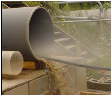
Bild 61: Einspülen der Düse
