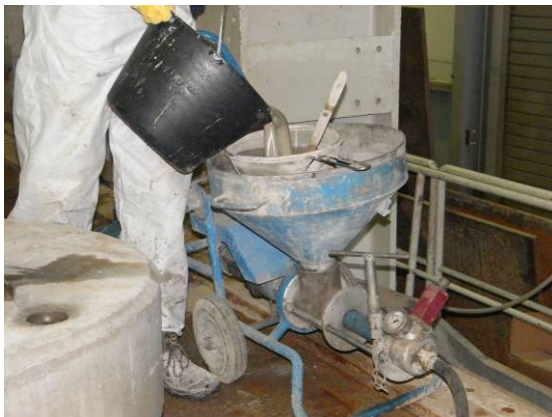
Bild 148 Befüllen der Förderpumpe mit Zementleim (links); Injektion in Fehlstelle (rechts)
