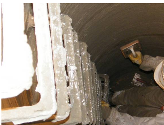
Bild 54 Abreiben der Beschichtung im Bereich der Ringfugen mit einem Schwammbrett (links), Blick in den beschichteten Schacht (rechts)
