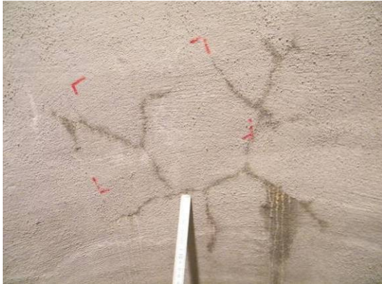
Bild 64 Beschichtung unter Grundwassereinwirkung: Risse in der Beschichtung mit nicht abflusswirksamen Feuchtefahnen im Bereich einer Hohlstelle aus planmäßiger Verbundschwächung durch Trennmittel (FU 6p, links), Feuchtefahnen auf der Schachtwand bis auf die Berme (rechts)
