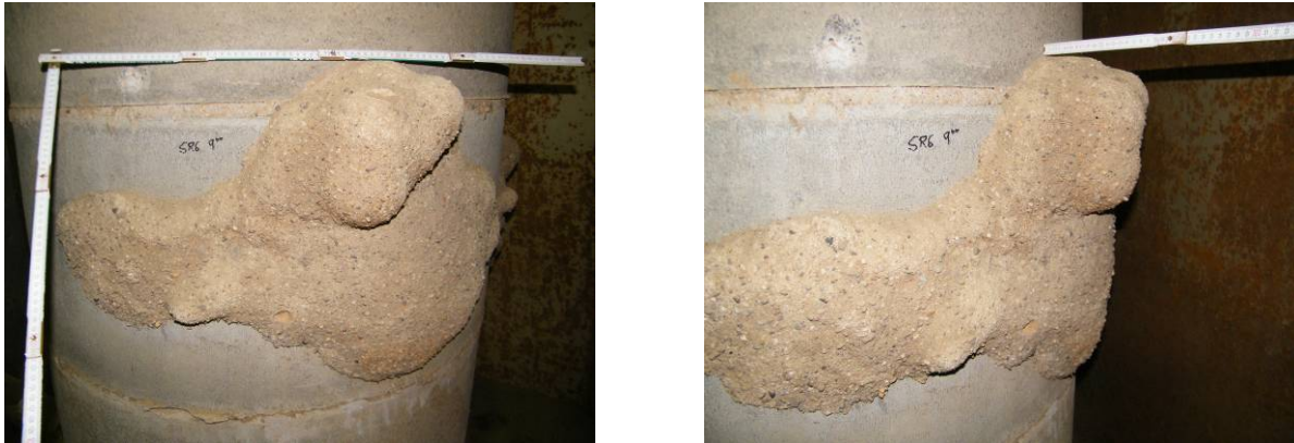
Bild 138 Polyurethan-Injektionskörper an der sanierten Schadstelle FU 6 in seiner Ausdehnung (links) und Mächtigkeit (rechts)
