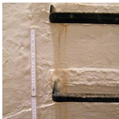
Bild 118 Ultracoat-Beschichtung unter Grundwassereinwirkung: Wassertropfen an einer Steigbügeleinbindung (links) und bräunliche Fließspuren unterhalb dieser zum Ende der Beobachtungszeit (rechts)
