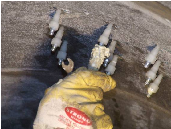
Bild 130 Injektion von Polyurethan durch Konuspacker an der Schadstelle FU 4 (links); abgedichtete Fehlstelle LS 3 nach Abschluss der Injektionsarbeiten (rechts)
