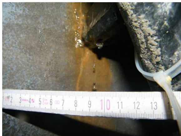
Bild 77 Beschichtung unter Grundwassereinwirkung: Abtropfendes Wasser, eingedrungen an dem linken Einbindebereich des vierten Steigbügels (links), Wasserfließspuren auf der Beschichtung bis in das Gerinne hinein (rechts)
