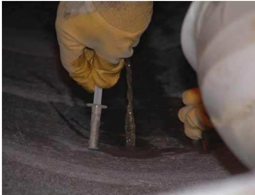
Bild 124 Lokale Abdichtung bei starkem Wassereindrang mittels „Trockenmörtel-Injektion“ (links); abgedichtete Fehlstellenbereiche (rechts)
