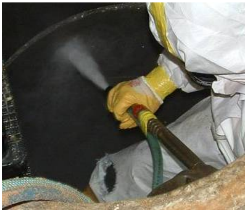
Bild 73 Wasser-Feststoff-Strahlen mit Hochdruck und Kaltwasser (links), Ergebnis der Untergrundvorbereitung (rechts)
