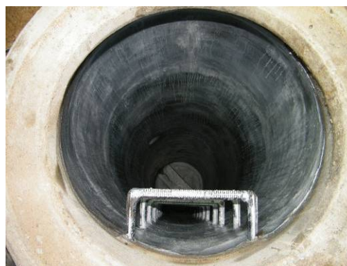
Bild 75 Auftragen des Mörtels (links), Blick in den beschichteten Schacht (rechts)
