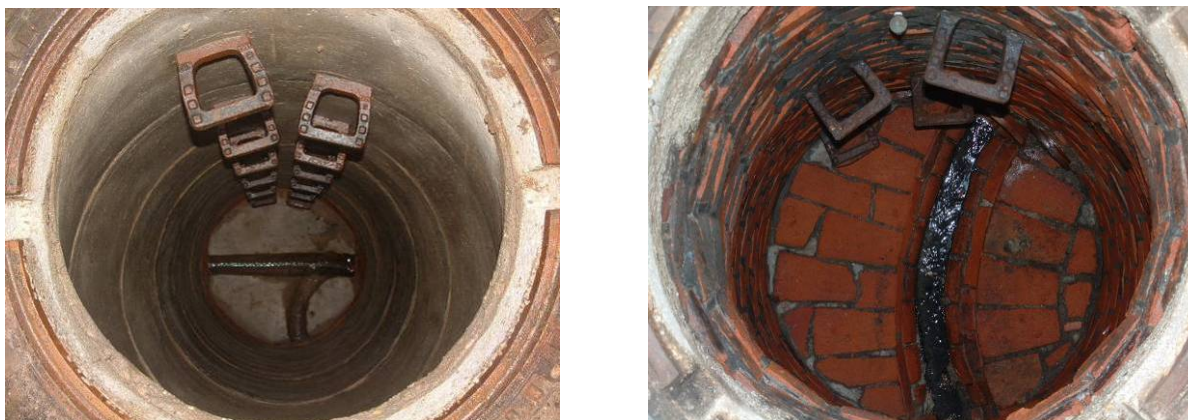
Bild 3 Ausgeführte Abwasserschächte: Abwasserschacht aus Beton (links), Abwasserschacht aus Mauerwerk (rechts)
