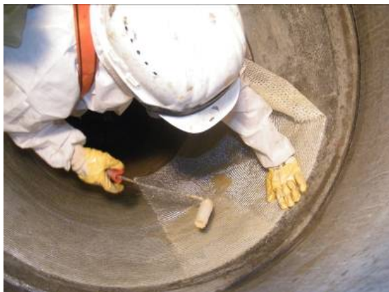
Bild 86 Laminierarbeiten vor der Beschichtung: Andrücken der Gewebematten (links), Blick in den mittels Laminat ausgekleideten Schacht (rechts)
