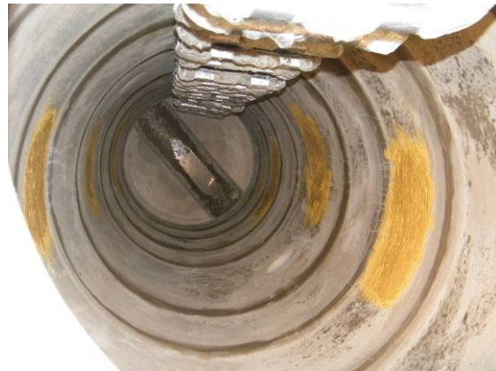
Bild 107 Reprofilierung der Ringfugen von Hand (links), händische Beschichtung der Bereiche von Hohlstellen aus planmäßiger Verbundschwächung durch Trennmittel (rechts)
