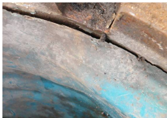
Bild 31 Beispiele für die Ablösung des Beschichtungsmaterials in Form von wassergefüllten Blasen mit Wasseraustritt im Schachtunterteil (links) und im Einstiegsbereich (rechts)
