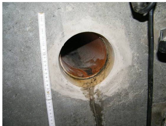
Bild 43 Wassereindrang durch undichte Rohranbindungen DN 150: Steinzeug (links) und Kunststoff (rechts)
