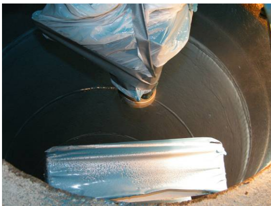
Bild 101 Anschleudern des Beschichtungsmaterials (links), Blick in den beschichteten Schacht (rechts)
