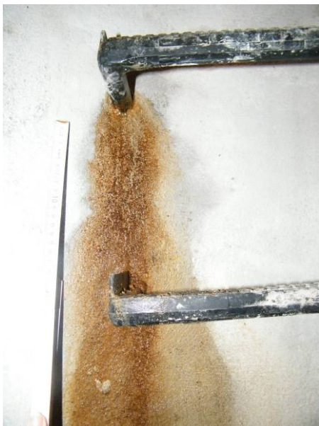
Bild 65 Beschichtung unter Grundwassereinwirkung: Geringfügiger Wassereindrang an der linken Einbindestelle des vierten Steigbügels von unten (links), Schmutzanhaftungen auf der Beschichtung im Bereich eines Risses (rechts)
