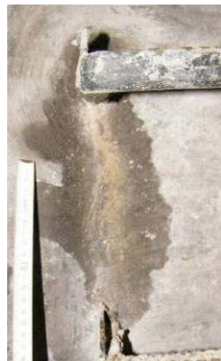
Bild 82 Feuchtigkeit auf der Beschichtung unterhalb eines Risses im Bereich einer Hohlstelle aus planmäßiger Verbundschwächung durch Trennmittel (FU 6p, links), Feuchtfahne unterhalb des linken Einbindebereichs des vierten Steigbügels (rechts)
