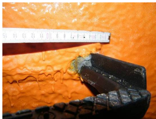
Bild 96 Eprocoat-Beschichtung ohne Grundwassereinwirkung: Bläschen in der Beschichtungsoberfläche (links), Beispiel für einen stärker strukturierten Bereich der Beschichtung und nicht vollständig mit Beschichtungsmaterial umschlossene Steigbügleinbindung (rechts)
