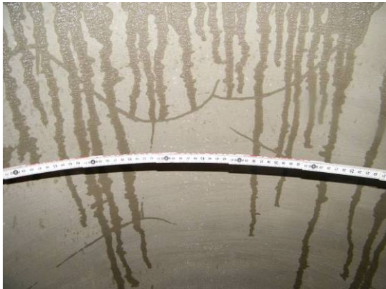
Bild 48 Zustand der Beschichtung ohne Grundwassereinwirkung: Risse erkennbar nach Befeuchten der Beschichtungsfläche mit Wasser (links), Detailbild eines Risses innerhalb einer Hohlstelle (Rissverlauf mit roten Pfeilen angezeigt, rechts)
