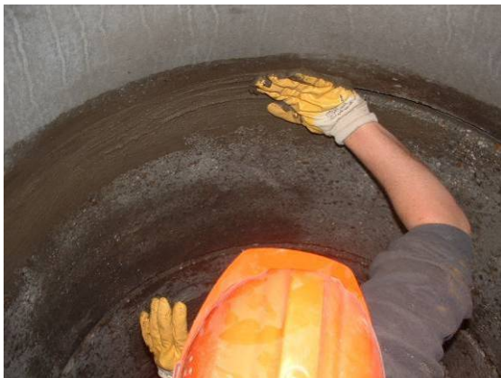
Bild 107 Reprofilierung der Ringfugen von Hand (links), händische Beschichtung der Bereiche von Hohlstellen aus planmäßiger Verbundschwächung durch Trennmittel (rechts)
