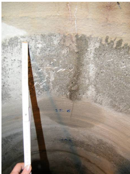
Bild 137 Abgedichtete Schachtringfugen SF 6 und 7: Geringfügiger Feuchteindrang (links) und rötliche Verfärbung des Mörtels (rechts)
