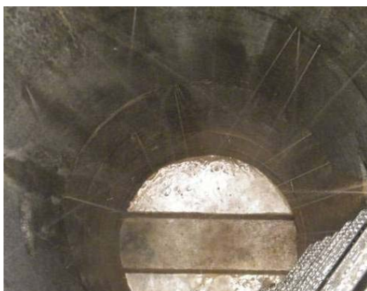
Bild 90 Autoschicht-Beschichtung unter Grundwassereinwirkung: Undichtigkeiten in allen Schachtringfugen (links), Detailaufnahme einer Ringfuge mit Wassereindrang (rechts)
