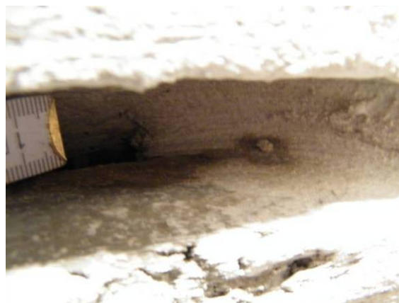
Bild 126 Partielle Abdichtung einer Schachtringfuge: Beispiel für einen geringen Feuchteeintrag an einer Schadstelle bedingt durch Hinterläufigkeit (links), Feuchteindrang neben einer Reparaturstelle (rechts)
