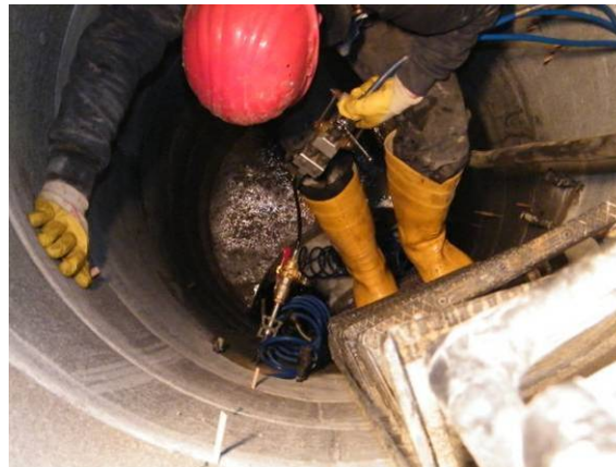
Bild 156 Einschlagen eines Injektionspackers (links), Verpressen des Acrylatgels an einem Seitenzulauf DN 150 (rechts)
