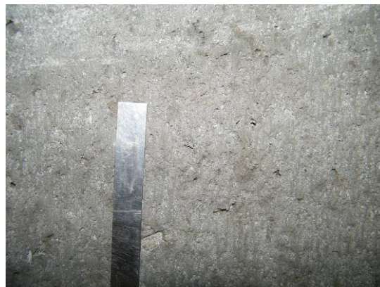
Bild 99 Hochdruckwasserstrahlen mit Kaltwasser (links), Ergebnis der Untergrundvorbereitung (rechts)
