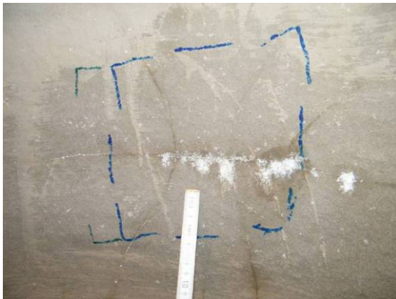
Bild 57 KS-ASS-Beschichtung unter Grundwassereinwirkung: Risse im Bereich einer Hohlstelle aus planmäßiger Verbundschwächung durch Trennmittel mit weißen Ausblühungen (links) und Beispiel für Risse und Feuchtefahnen im Bereich einer unplanmäßigen Hohlstelle (rechts)
