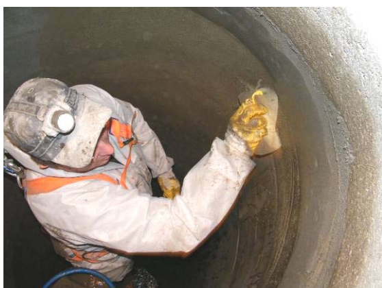
Bild 69 Abreiben der Mörteloberfläche mit einem Schwamm (links), Blick in den beschichteten Schacht (rechts)
