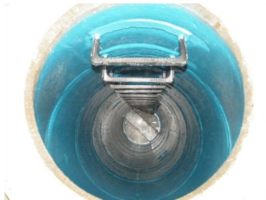
Bild 101 Anschleudern des Beschichtungsmaterials (links), Blick in den beschichteten Schacht (rechts)
