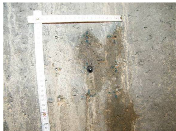
Bild 145 Feuchtefahnen an den abgedichteten Schachtringfugen SF 5 und 6 (links); Feuchtefahnen im Bereich einer sanierten Schadstelle FU 2 (rechts)
