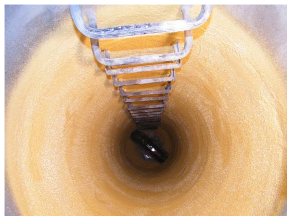
Bild 108 Auftragen der Beschichtung mittels handgeführter Spritzdüse (links), Blick in den beschichteten Schacht (rechts)
