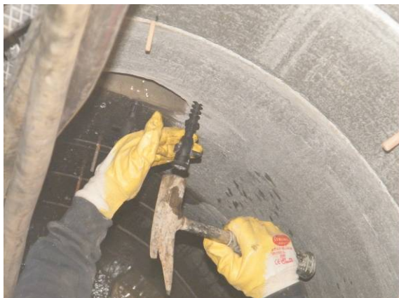
Bild 156 Einschlagen eines Injektionspackers (links), Verpressen des Acrylatgels an einem Seitenzulauf DN 150 (rechts)
