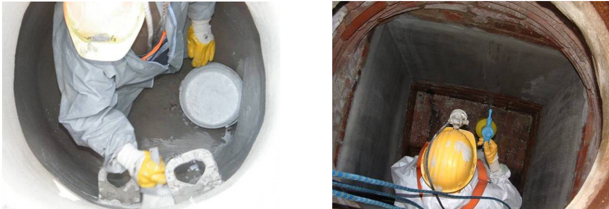
Bild 187 Aufquasten einer synthetischen Emulsion (links) und Aufsprühen eines wachshaltigen Nachbehandlungsmittels auf eine kurz zuvor applizierte Mörtelbeschichtung (rechts)
