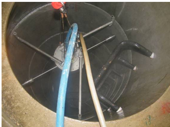
Bild 60 Maschinelle Untergrundvorbereitung mittels rotierender Reinigungsdüsen (links), Ergebnis der Untergrundvorbereitung (rechts)
