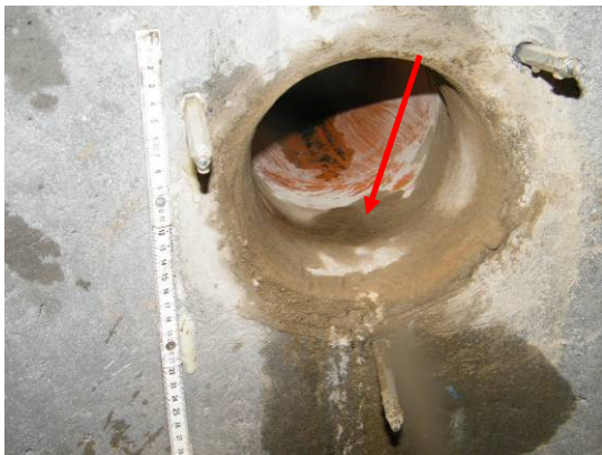
Bild 152 Ergebnis der Abdichtungsarbeiten an Kunststoffrohren: Beispiel für eine undichte Rohranbindung DN 150 mit nachdrückendem Wasser aus einem radialen Riss in der Verdämmung (vgl. roter Pfeil, links), erfolgreiche Abdichtung der Rohranbindung DN 300 (rechts)
