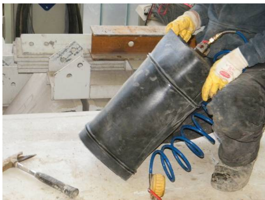
Bild 151 Herstellen einer temporären Abdichtung aus Absperrblase und Gummimantel einer Manschette DN 300 (links), Injektion eines Polyurethanharzes an einem Seitenzulauf DN 150 (rechts)
