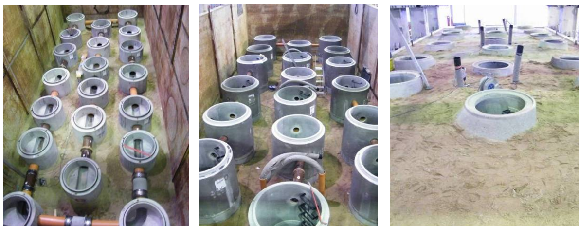
Bild 36 Einbau der Schächte im Großversuchsstand: Untere Rohrlage DN 300 (links); Mittlere Rohrlage DN 150 (mitte); Fertiggestellter Einbau (rechts)
