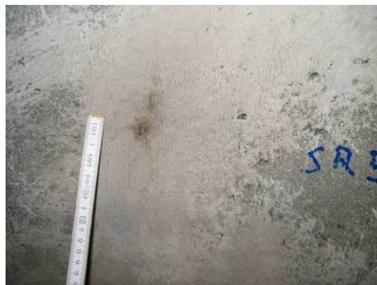
Bild 122 Abdichtungsergebnis mit Mörteln: Feuchtfahnen an den höher liegenden Reparaturstellen des Schachtes in SF 5 (links) und LS 5 (rechts)
