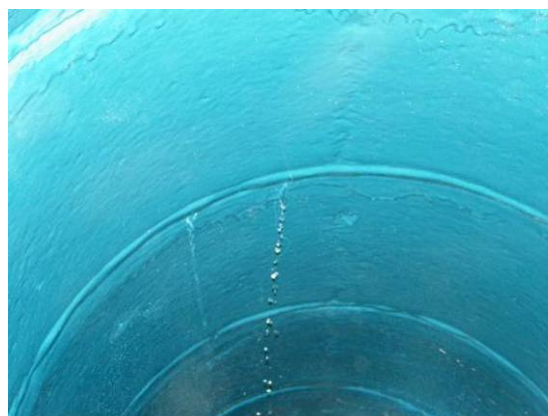
Bild 103 Oldodur-Beschichtung mit Grundwassereinwirkung: Wassertropfen an einer Steigbügelleinbindung (links), Wassereindrang im Bereich der obersten Schachtringfuge SF 7p (rechts)
