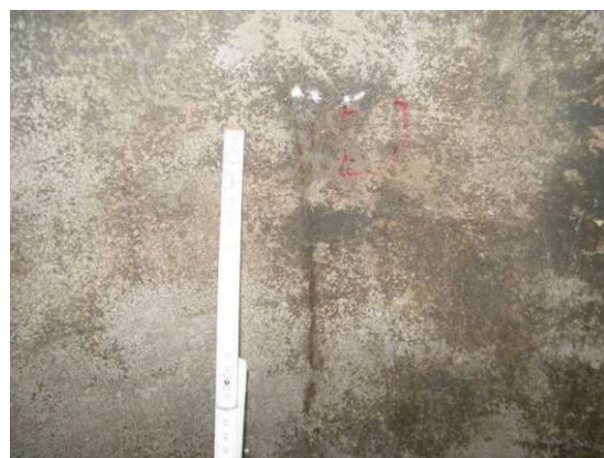
Bild 76: Beschichtung unter Grundwassereinwirkung: Weiße Ausblühungen an einem Riss im Bereich einer Hohlstelle aus planmäßiger Verbundschwächung durch Trennmittel (FU 2) ohne Feuchteindrang (links) und mit geringer Feuchtefahne (rechts)
