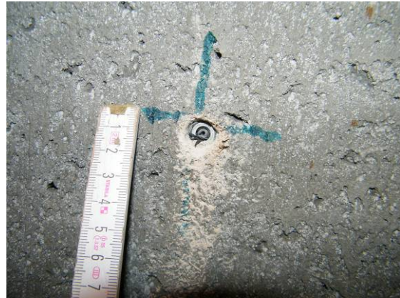
Bild 130 Injektion von Polyurethan durch Konuspacker an der Schadstelle FU 4 (links); abgedichtete Fehlstelle LS 3 nach Abschluss der Injektionsarbeiten (rechts)
