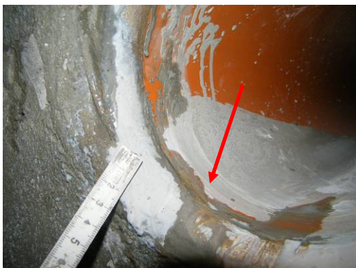
Bild 162 Undichte Rohranbindungen DN 150 mit nachdrückendem Wasser aus einem radialen Riss in der Verdämmung des Kunststoff- (vgl. roter Pfeil, links) und Steinzeugrohres (vgl. roter Pfeil, rechts)
