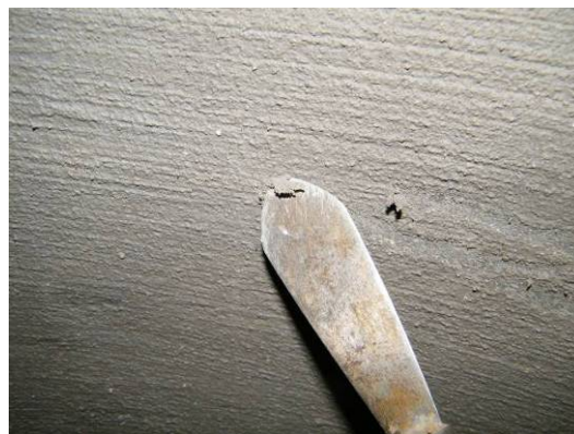
Bild 83 Dunkle Färbung der Beschichtung im Bereich einer lokalen Fehlstelle in Schachtring 3 (links), minderfestes Beschichtungsmaterial im unteren Bereich des Schachtes kann mit einem Spachtel ca. 2 mm tief abgeschabt werden (rechts)
