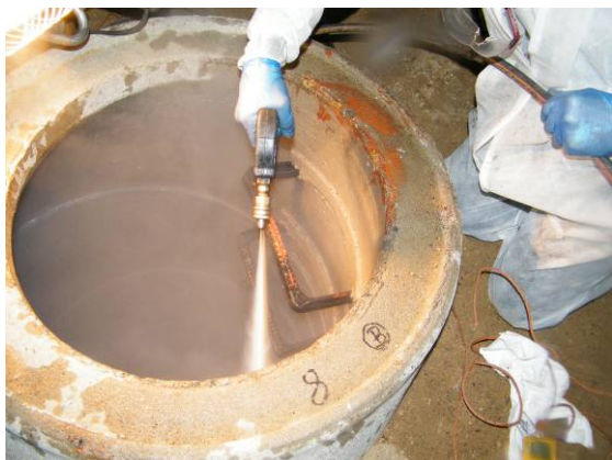
Bild 113 Abspülen der Schachtwand ohne Reinigungsdüse (links), Ergebnis der Untergrund-vorbereitung (rechts)
