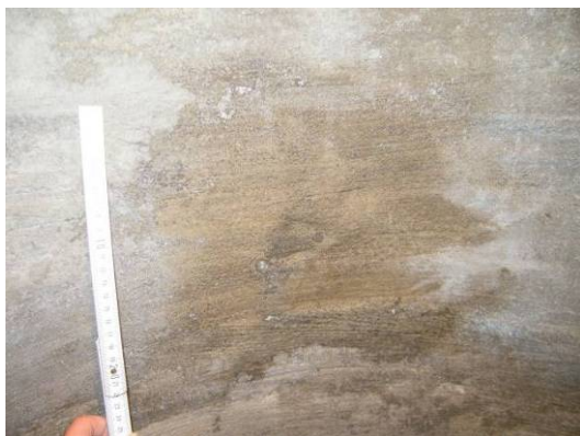
Bild 83 Dunkle Färbung der Beschichtung im Bereich einer lokalen Fehlstelle in Schachtring 3 (links), minderfestes Beschichtungsmaterial im unteren Bereich des Schachtes kann mit einem Spachtel ca. 2 mm tief abgeschabt werden (rechts)
