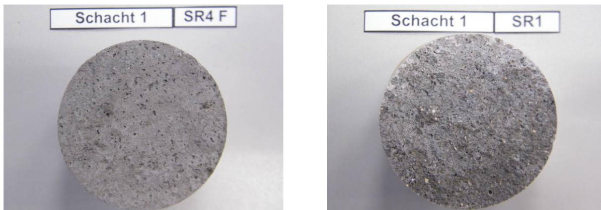
Bild 72 Bruchstellen, exemplarisch für ein vollständiges Versagen in der Verbundfuge (links) sowie im Beschichtungsmörtel (rechts)
