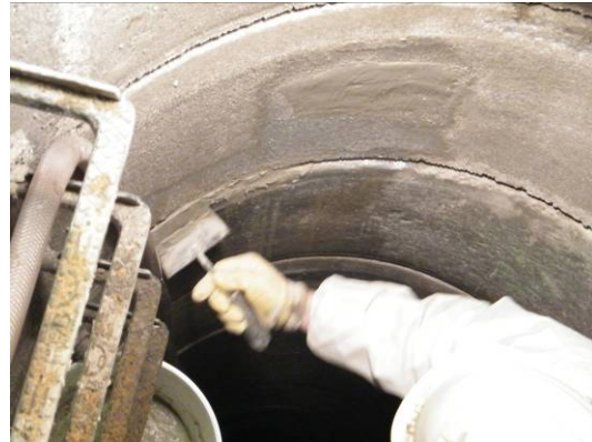
Bild 124 Lokale Abdichtung bei starkem Wassereindrang mittels „Trockenmörtel-Injektion“ (links); abgedichtete Fehlstellenbereiche (rechts)
