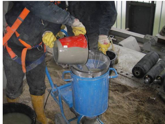
Bild 161 Abdichtung der Rohranbindungen mittels Zementleiminjektion: Wassereindrang durch offenen Packer (links), Befüllen der Injektionspumpe mit Zementleim (rechts)
