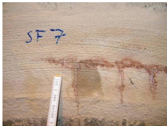
Bild 137 Abgedichtete Schachtringfugen SF 6 und 7: Geringfügiger Feuchteindrang (links) und rötliche Verfärbung des Mörtels (rechts)
