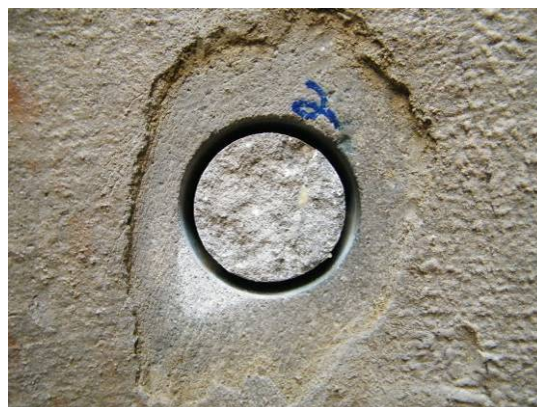
Bild 26 Deutlicher Substanzverlust der Beschichtung: Minderfester, in Auflösung befindlicher Beschichtungsmörtel (links) und weiche Beschichtung auf fester Reprofilierung im Bereich einer Haftzugprüfung (rechts)
