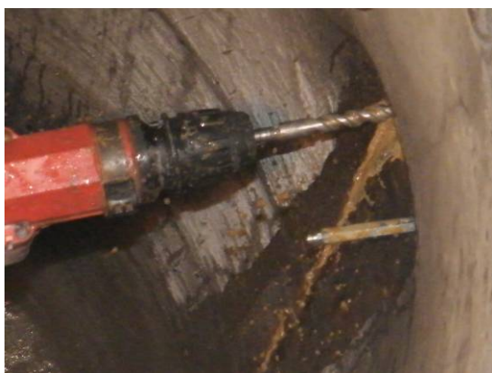
Bild 135 Bohren eines Packerlochs (links), ausgetretenes und ausreagiertes Polyurethanharz aus der verdämmten Schachtringfuge SF 2 (rechts)
