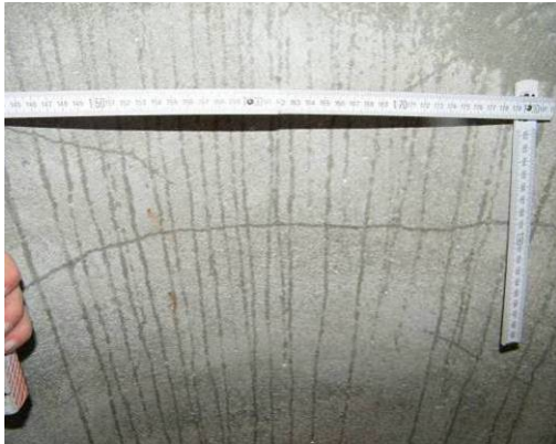
Bild 63 Beschichtung ohne Grundwassereinwirkung nach Befeuchten der Oberfläche: Risse in der Beschichtung im Bereich einer unplanmäßigen Hohlstelle (links), Riss im Bereich einer Hohlstelle aus planmäßiger Verbundschwächung durch Trennmittel (FU 4, rechts)
