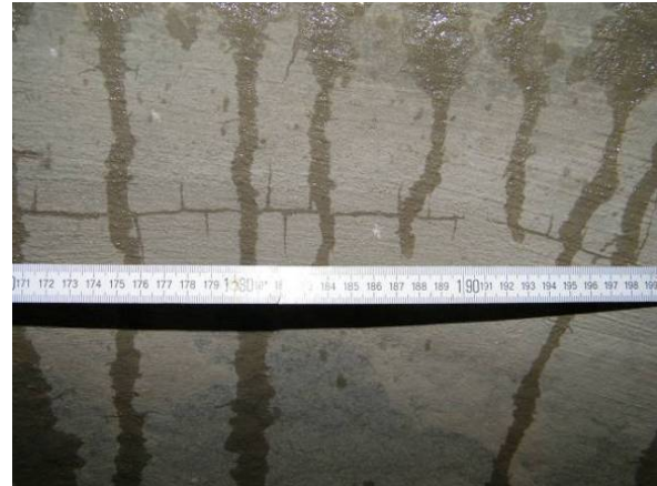
Bild 55 Zustand der Beschichtung ohne Grundwassereinwirkung nach Befeuchten der Oberfläche: Risse im Bereich einer Hohlstelle aus planmäßiger Verbundschwächung durch Trennmittel (links); Beispiel für einen Riss in einer Schachtringfuge (rechts)
