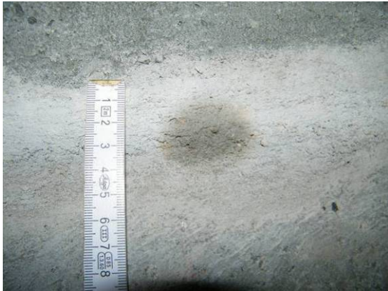
Bild 131 Feuchtefahnen an sanierten Schadstellen: Bereich einer Schachtringfuge SF 5 (links); geringfügiger Wassereindrang bei LS 3 (rechts)
