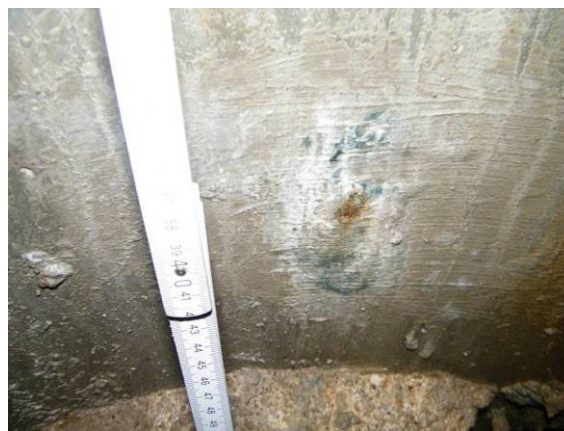
Bild 125 Schmutzwasserfließspuren im Bereich der Reparaturstelle SF 1 (links), abgedichtete Fehlstelle LS SU mit blau-weißer Verfärbung (rechts)
