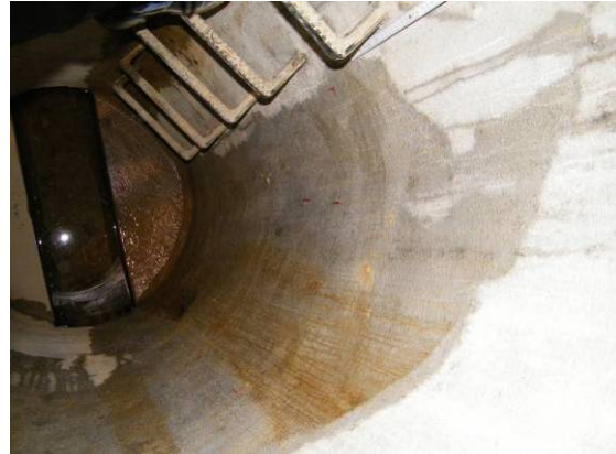
Bild 64 Beschichtung unter Grundwassereinwirkung: Risse in der Beschichtung mit nicht abflusswirksamen Feuchtefahnen im Bereich einer Hohlstelle aus planmäßiger Verbundschwächung durch Trennmittel (FU 6p, links), Feuchtefahnen auf der Schachtwand bis auf die Berme (rechts)
