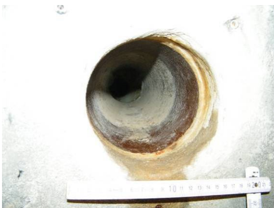
Bild 154 Ergebnis der Abdichtungsarbeiten an Rohranbindungen DN 150: Undichte Anbindung des Steinzeug- (links) und des Kunststoffrohres (rechts)
