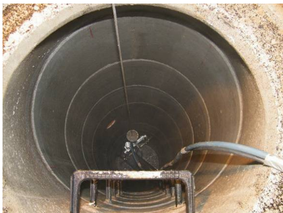
Bild 52 Maschinelle Untergrundvorbereitung mittels rotierender Reinigungsdüsen (links), Ergebnis der Untergrundvorbereitung (rechts)
