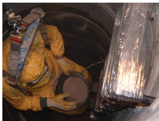
Bild 94 Auftragen des Primers (links), Bestreuen des klebeaktiven Primers mit Quarzsand (rechts)
