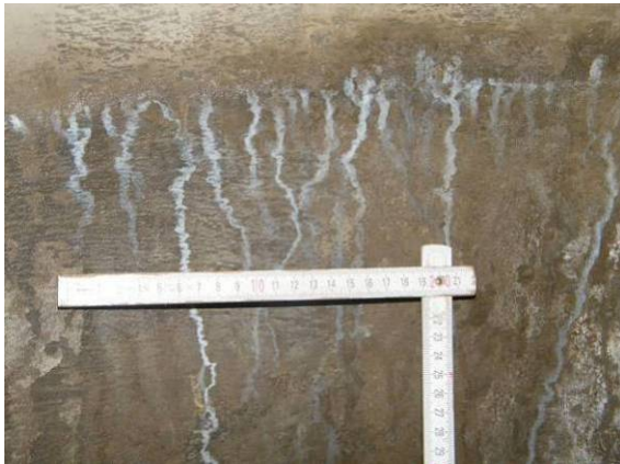
Bild 123 Abdichtungsergebnis mit Mörteln: Feuchtefahnen in den unteren Bereichen des Schachtes an SF 3 (links) und LS 3 (rechts)
