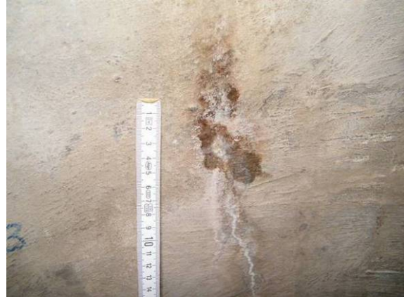
Bild 123 Abdichtungsergebnis mit Mörteln: Feuchtefahnen in den unteren Bereichen des Schachtes an SF 3 (links) und LS 3 (rechts)
