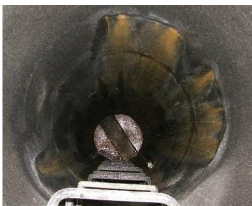
Bild 91 Wassereindrang mit Schmutzfließspuren an allen Schachtringfugen (links), Materialprobe aus einem Bereich mit einer Undichtigkeit - fehlendes Material mit einem Durchmesser von ca. 0,8 mm (rechts)
