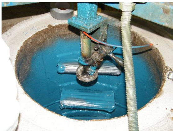
Bild 15 Anschleudern einer polymeren Beschichtung (links), Nacharbeiten einzelner Stellen mit einem Pinsel (rechts)
