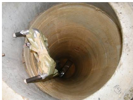
Bild 86 Laminierarbeiten vor der Beschichtung: Andrücken der Gewebematten (links), Blick in den mittels Laminat ausgekleideten Schacht (rechts)
