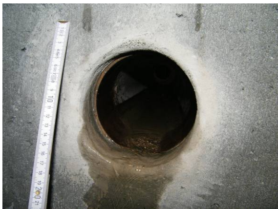
Bild 43 Wassereindrang durch undichte Rohranbindungen DN 150: Steinzeug (links) und Kunststoff (rechts)
