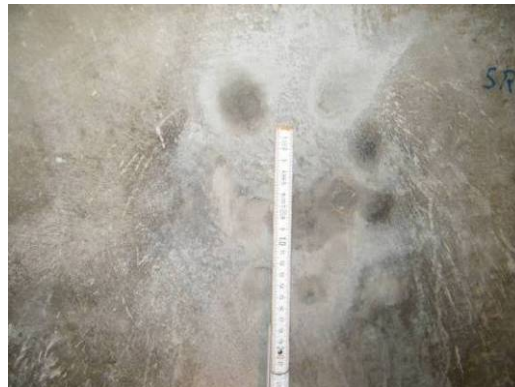
Bild 136 Abgedichtete Fehlstellen FU 2 mit Feuchtfahnen und bräunlichen Anhaftungen von eindringendem Injektionsmaterial (links) und FU 4 mit geringfügigen Feuchtfahnen (rechts)
