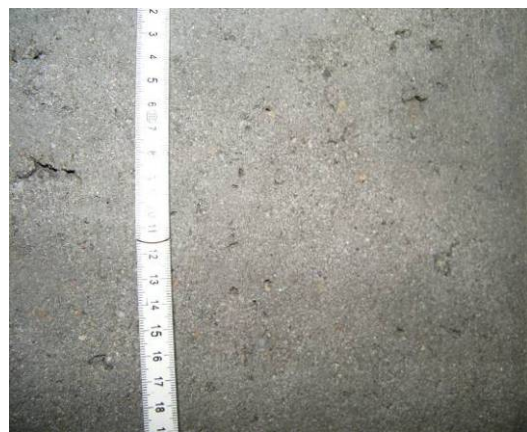
Bild 73 Wasser-Feststoff-Strahlen mit Hochdruck und Kaltwasser (links), Ergebnis der Untergrundvorbereitung (rechts)
