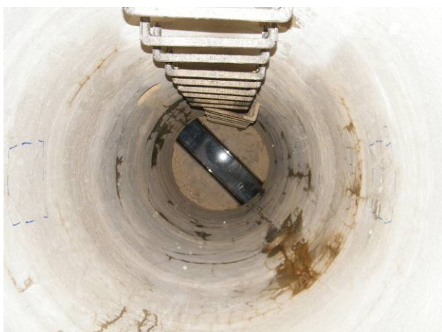
Bild 59 Blick in den Schacht mit trockener Berme
