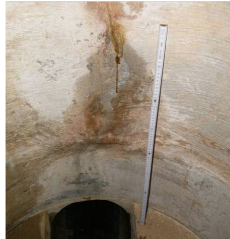
Bild 129 Minderfeste Mörtelschlämme kann mit einem Zollstock abgeschabt werden (links); bereichsweise dunkle Verfärbungen der Mörtelschlämme ohne erkennbare Undichtigkeiten (rechts)
