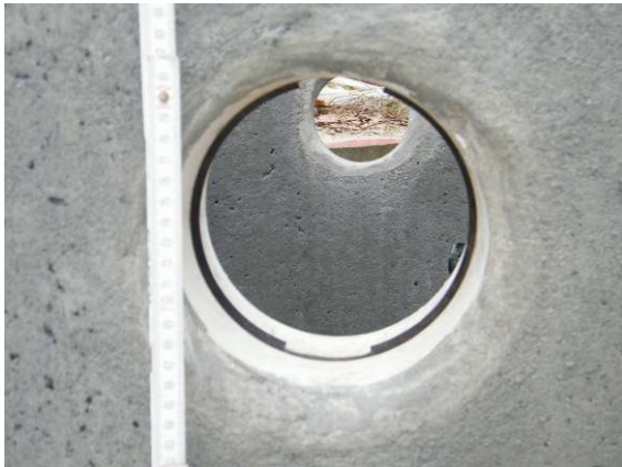
Bild 38 Schäden an den Rohreinbindungen: bereichsweise fehlende Dichtung am Anschluss für ein Kunststoffrohr DN 150 (links) und an einem Steinzeugrohr DN 300 (rechts)
