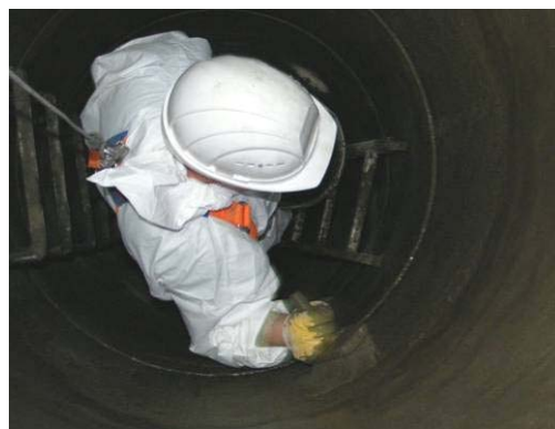
Bild 74 Vornässen des Betonuntergrunds (links), Aufquasten der Haftbrücke (rechts)
