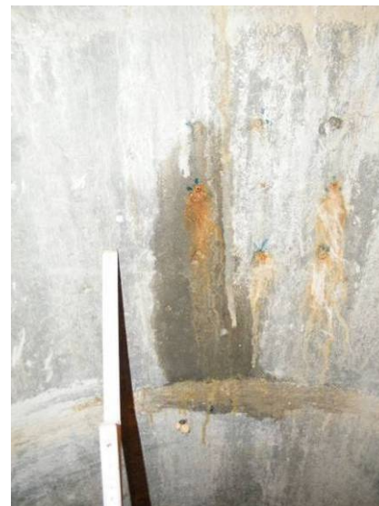
Bild 132 Schadstelle „flächige Undichtigkeit“ FU 2 während der Beobachtungszeit: größere Ausdehnung der Feuchtefahne etwa 16 Wochen nach Sanierung (links) und geringere Ausdehnung nach etwa 19 Wochen (rechts)
