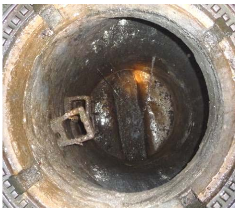
Bild 33 lokale Undichtigkeiten in einer Ringfuge eines Betonfertigteil-Schachtes (links), flächig durchfeuchtetes Mauerwerk (rechts)
