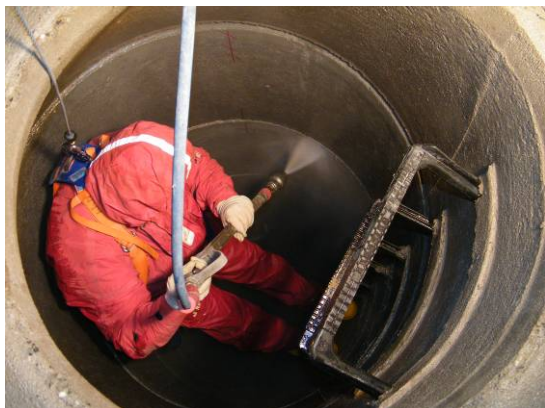
Bild 99 Hochdruckwasserstrahlen mit Kaltwasser (links), Ergebnis der Untergrundvorbereitung (rechts)
