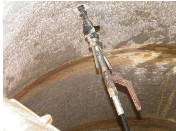
Bild 144 Einlegen einer Hinterfüllschnur in die Schachtringfuge (links); Verpressen einer einzelnen Schadstelle (rechts)
