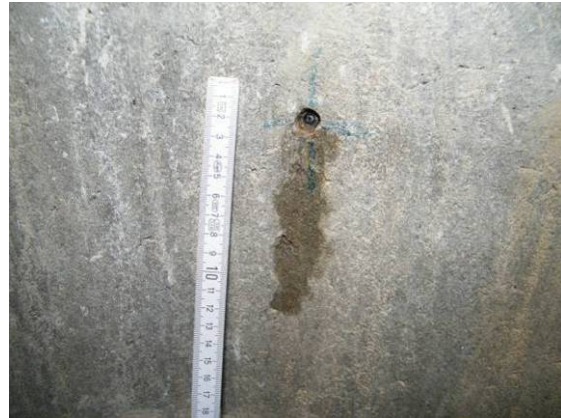
Bild 131 Feuchtefahnen an sanierten Schadstellen: Bereich einer Schachtringfuge SF 5 (links); geringfügiger Wassereindrang bei LS 3 (rechts)
