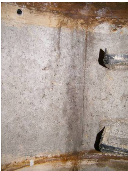
Bild 145 Feuchtefahnen an den abgedichteten Schachtringfugen SF 5 und 6 (links); Feuchtefahnen im Bereich einer sanierten Schadstelle FU 2 (rechts)
