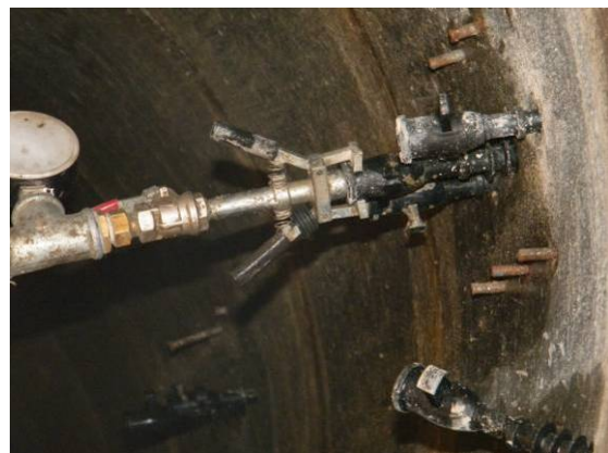
Bild 148 Befüllen der Förderpumpe mit Zementleim (links); Injektion in Fehlstelle (rechts)
