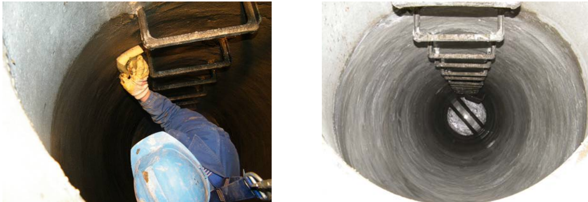
Bild 81 Abreiben der Beschichtung mit einem feuchten Schwamm (links), Blick in den beschichteten Schacht (rechts)
