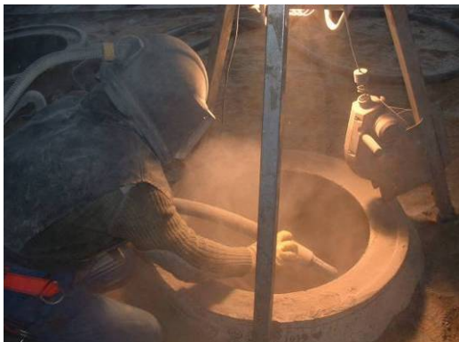
Bild 106 Untergrundvorbereitung mittels Feststoffstrahlen im Bereich des Schachtkonus (links), Ergebnis der Untergrundvorbereitung (rechts)
