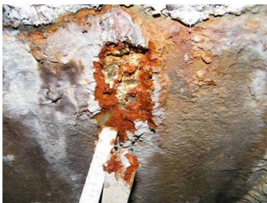
Bild 26 Deutlicher Substanzverlust der Beschichtung: Minderfester, in Auflösung befindlicher Beschichtungsmörtel (links) und weiche Beschichtung auf fester Reprofilierung im Bereich einer Haftzugprüfung (rechts)
