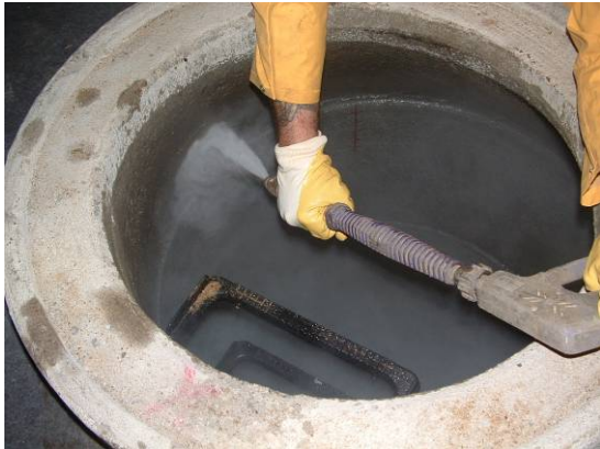
Bild 93 Hochdruckwasserstrahlen mit Heißwasser (links), Ergebnis der Untergrundvorbereitung (rechts)
