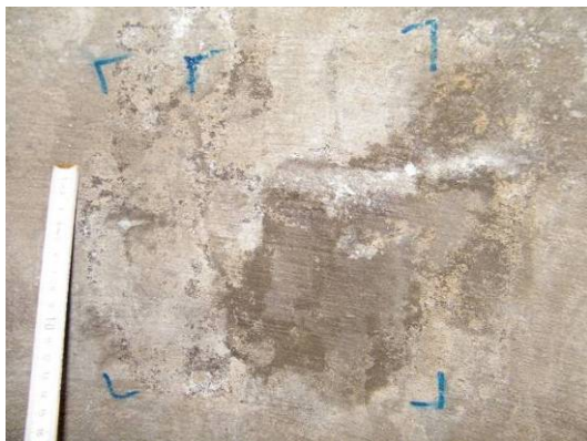
Bild 82 Feuchtigkeit auf der Beschichtung unterhalb eines Risses im Bereich einer Hohlstelle aus planmäßiger Verbundschwächung durch Trennmittel (FU 6p, links), Feuchtfahne unterhalb des linken Einbindebereichs des vierten Steigbügels (rechts)
