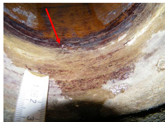
Bild 162 Undichte Rohranbindungen DN 150 mit nachdrückendem Wasser aus einem radialen Riss in der Verdämmung des Kunststoff- (vgl. roter Pfeil, links) und Steinzeugrohres (vgl. roter Pfeil, rechts)
