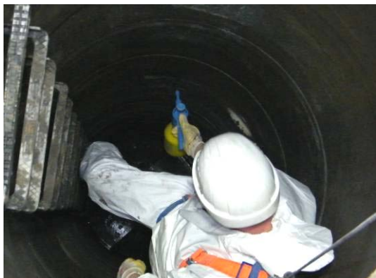
Bild 74 Vornässen des Betonuntergrunds (links), Aufquasten der Haftbrücke (rechts)
