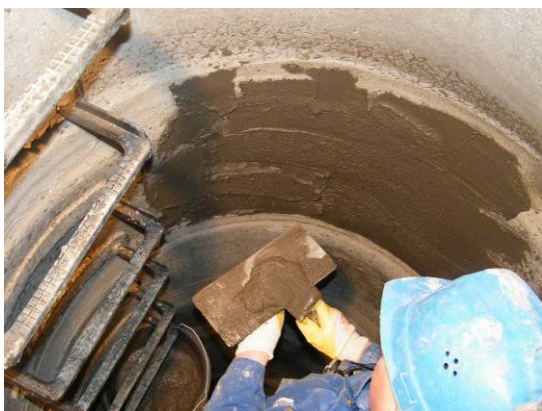
Bild 80 Materialauftrag von Hand mittels Kelle und Glätter (links) und im Nassspritzverfahren (rechts)
