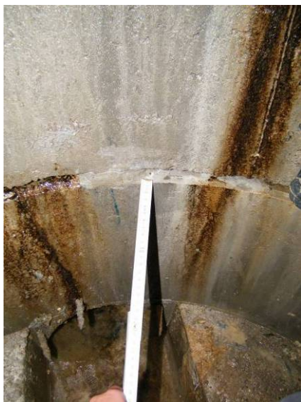
Bild 125 Schmutzwasserfließspuren im Bereich der Reparaturstelle SF 1 (links), abgedichtete Fehlstelle LS SU mit blau-weißer Verfärbung (rechts)
