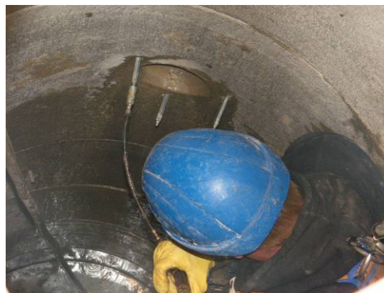
Bild 151 Herstellen einer temporären Abdichtung aus Absperrblase und Gummimantel einer Manschette DN 300 (links), Injektion eines Polyurethanharzes an einem Seitenzulauf DN 150 (rechts)
