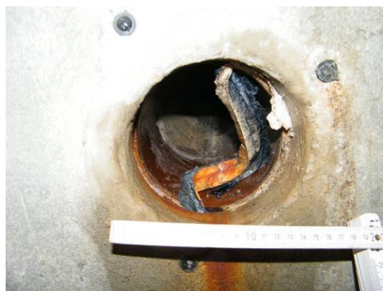
Bild 159 Undichte Steinzeug-Rohranbindung DN 150: Feuchtefahne und Fließspur mit Verfärbung beginnend im Sohlbereich (links), vollständig losgelöstes Acrylatgel im Ringraum, auf der Rohraußenseite schwarz verfärbt (rechts)
