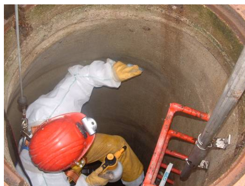
Bild 184 Untersuchung einer Hohlstelle auf Risse: Reinigung der Beschichtung mit einem Spachtel (links) und Nässen und Trocknen der Beschichtung (rechts)
