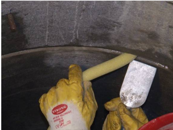
Bild 144 Einlegen einer Hinterfüllschnur in die Schachtringfuge (links); Verpressen einer einzelnen Schadstelle (rechts)
