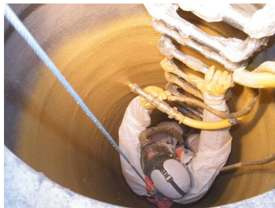
Bild 16 Applikation von polymeren Beschichtungen mittels Sprühverfahren (links) und Anspritzverfahren (rechts)
