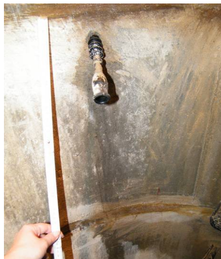
Bild 149 Erfolgreiche Abdichtung des Schadens FU 6 (links); Wassereindrang durch einen Packer im Bereich der Schachtringfuge 6 (rechts)
