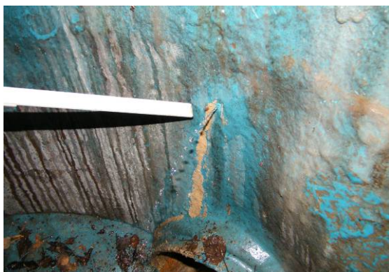
Bild 31 Beispiele für die Ablösung des Beschichtungsmaterials in Form von wassergefüllten Blasen mit Wasseraustritt im Schachtunterteil (links) und im Einstiegsbereich (rechts)
