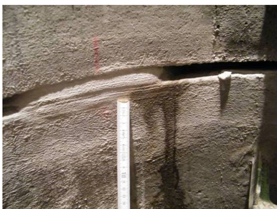
Bild 126 Partielle Abdichtung einer Schachtringfuge: Beispiel für einen geringen Feuchteeintrag an einer Schadstelle bedingt durch Hinterläufigkeit (links), Feuchteindrang neben einer Reparaturstelle (rechts)
