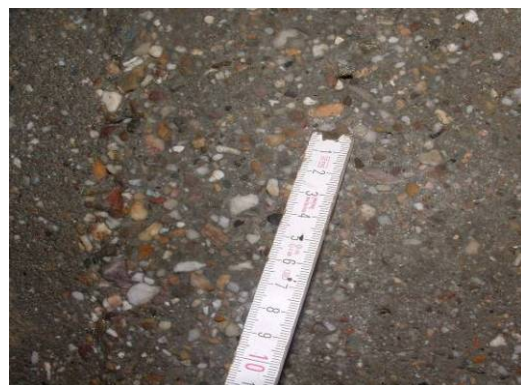
Bild 106 Untergrundvorbereitung mittels Feststoffstrahlen im Bereich des Schachtkonus (links), Ergebnis der Untergrundvorbereitung (rechts)
