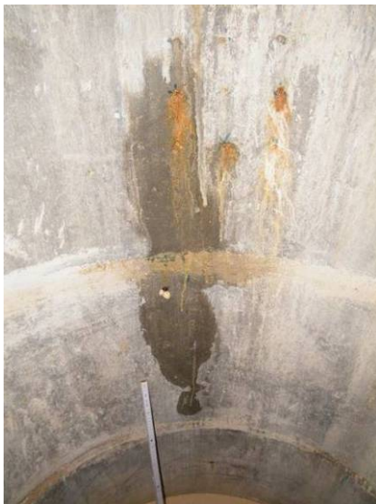
Bild 132 Schadstelle „flächige Undichtigkeit“ FU 2 während der Beobachtungszeit: größere Ausdehnung der Feuchtefahne etwa 16 Wochen nach Sanierung (links) und geringere Ausdehnung nach etwa 19 Wochen (rechts)
