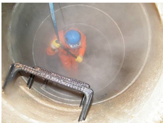
Bild 67 Hochdruckwasserstrahlen mit Heißwasser mittels handgeführter Lanze (links), Ergebnis der Untergrundvorbereitung (rechts)
