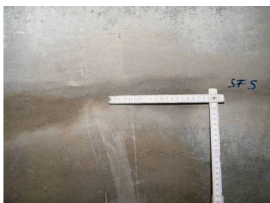
Bild 122 Abdichtungsergebnis mit Mörteln: Feuchtfahnen an den höher liegenden Reparaturstellen des Schachtes in SF 5 (links) und LS 5 (rechts)
