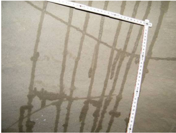
Bild 55 Zustand der Beschichtung ohne Grundwassereinwirkung nach Befeuchten der Oberfläche: Risse im Bereich einer Hohlstelle aus planmäßiger Verbundschwächung durch Trennmittel (links); Beispiel für einen Riss in einer Schachtringfuge (rechts)
