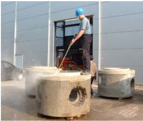
Abb. 128: Säuberung eines Schachtelementes mit Wasserhochdruck unter Verwendung einer Handlanze
