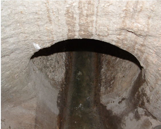
Abb. 103: Bündige Anbindung eines Zulaufes im Sohlenbereich
