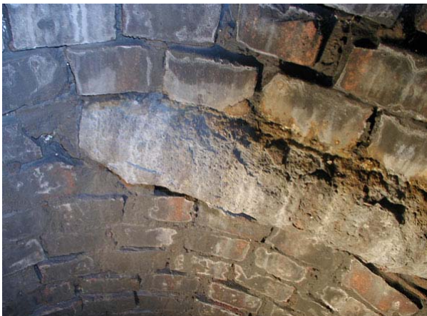
Abb. 57: Kreuzende Leitung im Wandungsbe- reich eines Mauerwerksschachtes
