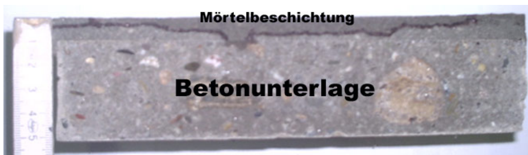
Abb. 108: Komplette Durchdringung einer Mörtelbeschichtung (Schacht Nr. 17) bei einer Wasserundurchlässigkeitsprüfung gemäß DIN 1048, Teil 5
