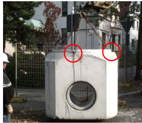
Abb. 19: Transport eines Schachtunterteils in die Baugrube (aus [26])
