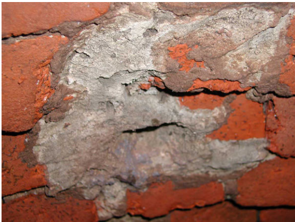
Abb. 55: Mit Mörtel ausgebesserte Fehlstelle in einem Mauerwerksschacht
