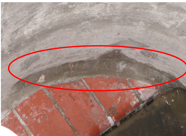
Abb. 105: Ausführung der Schachtsohlen. A: Gerinne und Berme beschichtet. B: Vorhandenes Gerinne und Berme an Beschichtung angebunden. C: Geklinkerte Berme mit Undichtigkeit im Übergangsbereich Wandung-Berme.
