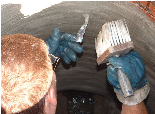
Abb. 75: Vorbeschichtung der Schachtwänden mit mineralischen Mörteln. A: Vorbeschichtung einer Mauerwerkswandung mit starker Fugenkorrosion. B: Vorbeschichtung einer korrodierten Betonwandung. C: Glätten der Oberfläche einer Vorbeschichtung. D: Komplett vorbeschichteter Mauerwerksschacht.
