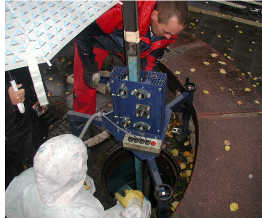
Abb. 85: Regenwetter während des Beschichtungsauftrages mit Polyurethan
