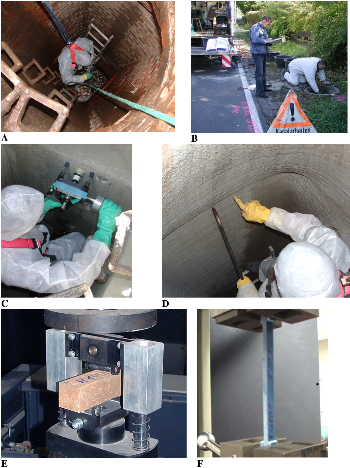
Abb. 39: Übersicht über das Untersuchungsprogramm: A: Untersuchung des IST-Zustands der zu sanierenden Schächte. B: Dokumentation der Baustellenbedingungen und Sanierungsausführung. C: Untersuchung der Qualität der ausgeführten Sanierungen vor Ort, Prüfung der Verbundfestigkeit. D: Untersuchung der Qualität der ausgeführten Sanierungen vor Ort, optische Inspektion mit Klangprobe. E: Prüfung der Materialkennwerte an Probestücken, 3-Punkt-Biegezugprüfung an einer Mörtelprobe. F: Prüfung der Materialkennwerte an Probestücken, Zugprüfung an einer Polyurethanprobe
