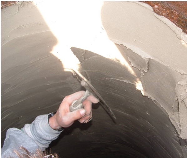
Abb. 89: Sonnenbestrahlung der Mörtelbeschichtung im Konusbereich eines Schachtes
