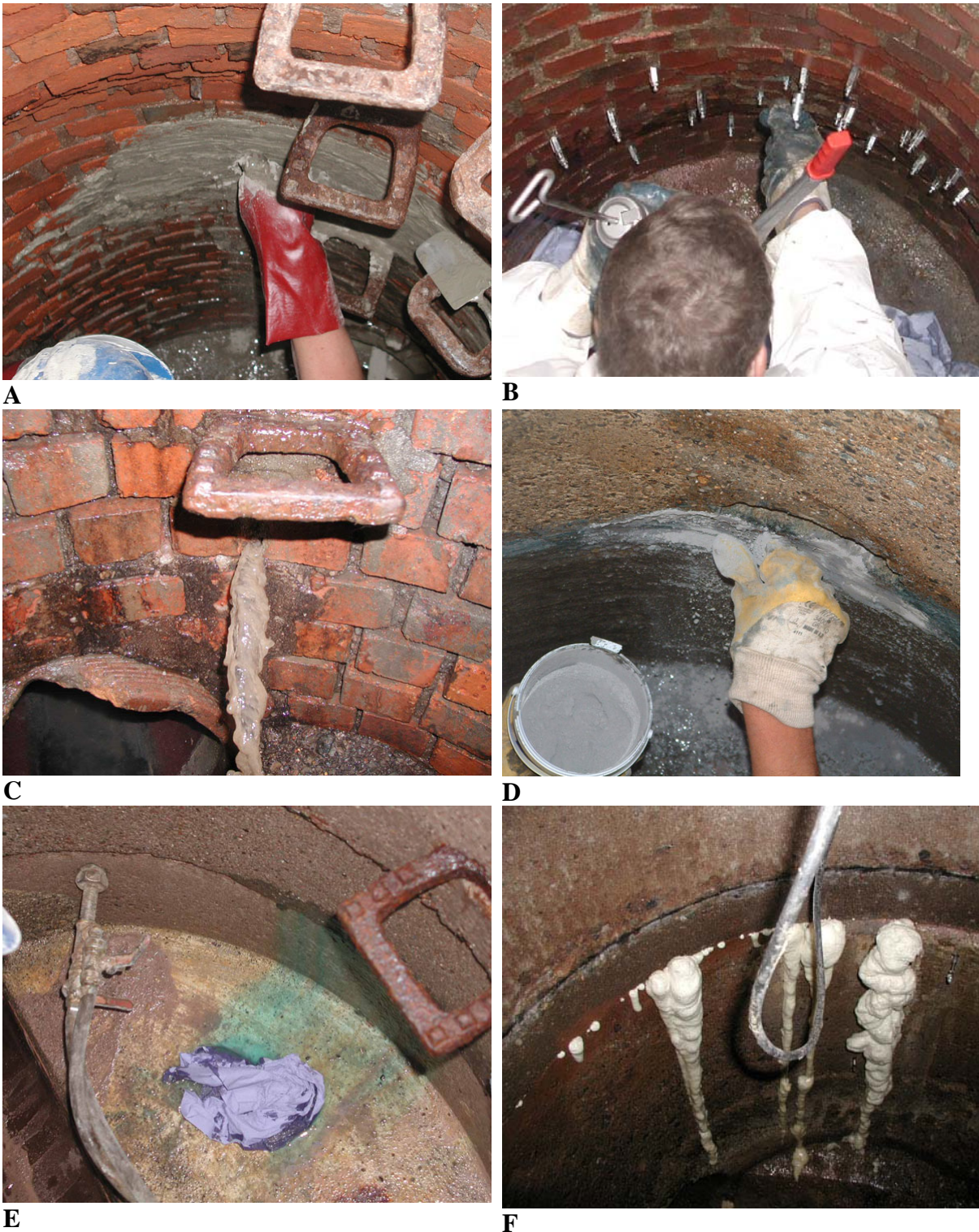
Abb. 74: Abdichtung der Schachtwandungen vor den Beschichtungen. A: Abdichtung einer Mauerwerkswandung mit Stopfmörtel. B: Abdichtung einer Mauerwerkswandung mit Injektionen. C: Hoher Wasserdruck hinter der Schachtwandung. D: Abdichtung eines Betonschachtes mit Stopfmörtel im Bereich einer Ringfuge. E: Injektion hinter eine Schachtwandung aus Beton. F: Durch undichte Stellen in einer Ringfuge eines Betonschachtes eintretendes Injektionsmaterial.
