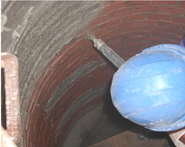
Abb. 82: Aufspritzen des Mörtels in einem Abstand von ca. 10 cm von der Schachtwandung
