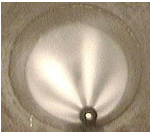
Abb. 22: Reinigung eines Abwasserkanals mittels Hochdruckspülung
