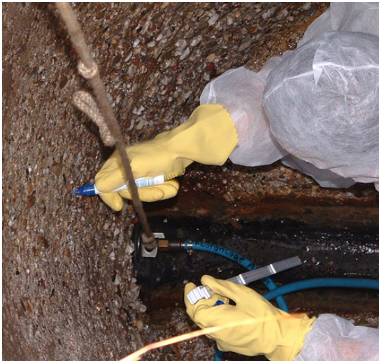
Abb. 49: Setzen einer Markierung 50 cm über dem Scheitel der untersten Rohreinbindung
