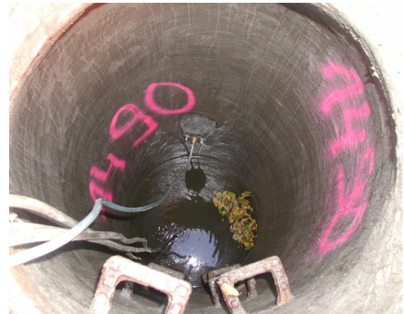
Abb. 17: Dichtheitsprüfung mit Wasser nach ATV-M 143, Teil 6 an einem in Betrieb befindlichen Schacht
