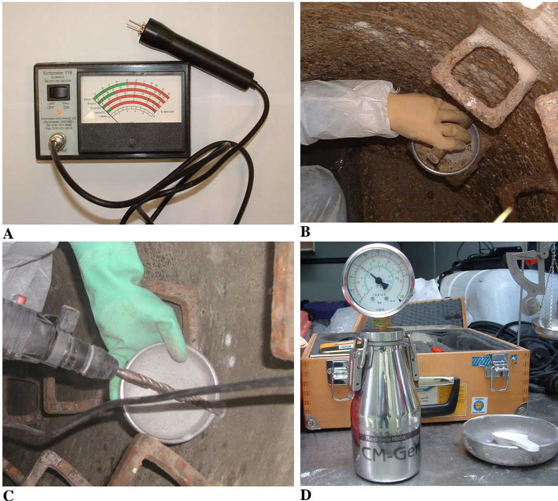
Abb. 44: Messung des Feuchtegehaltes der Schachtwandung. A: Analoges Oberflächenfeuchte-Messgerät „Elcometer 118“ [aus 85]. B: Probenentnahme im Schacht mit Hammer und Meißel für Messung nach CM-Methode. C: Probenentnahme im Schacht mit Bohrer für Messung nach CM-Methode. D: CM-Gerät mit Druckmanometer.
