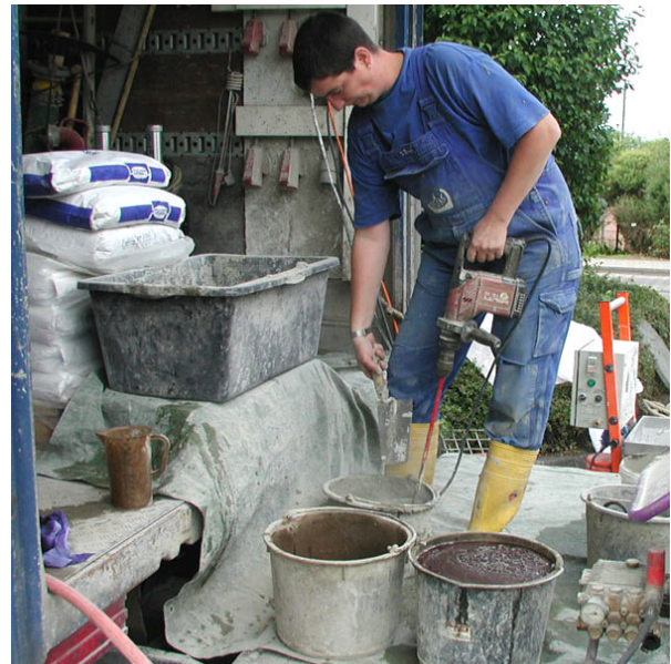
Abb. 77: Anmischen des Mörtels mit einem Handrührgerät
