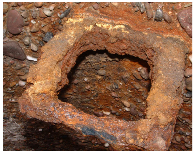
Abb. 61: Starke Korrosion eines Steigeisens ohne Kunststoffversiegelung
