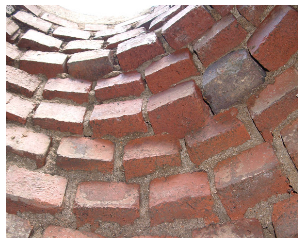
Abb. 6: Ausbildung des Schachthalses (Konus) in einem Mauerwerksschacht
