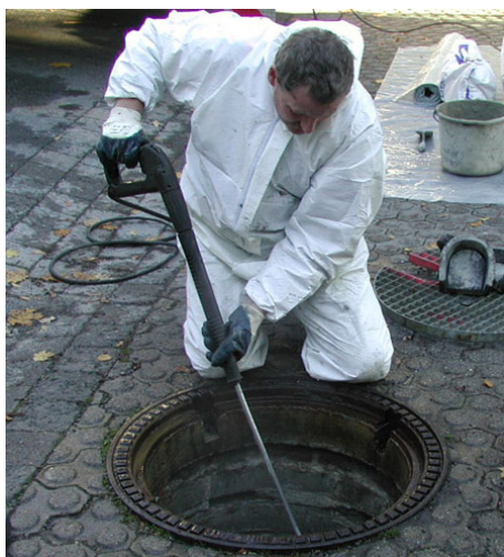
Abb. 35: Wasserhochdruckreinigung mit Handlanze
