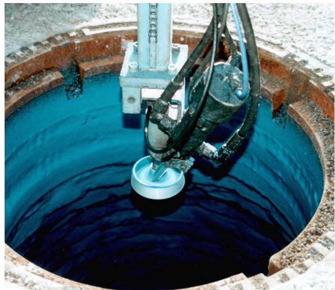
Abb. 34: Polyurethanbeschichtung mittels Sprüh – Schleudertechnik. A: Halterung und Führung der Schleuderscheibe. B: Schleuderscheibe mit Teller, Misch- und Aufsprüh-einheit [62].
