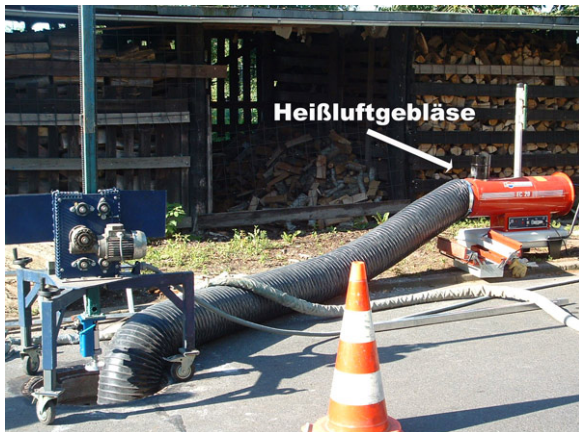
Abb. 84: Trocknung eines Schachtes mit einem Heißluftgebläse im Vorfeld des Beschichtungsauftrages
