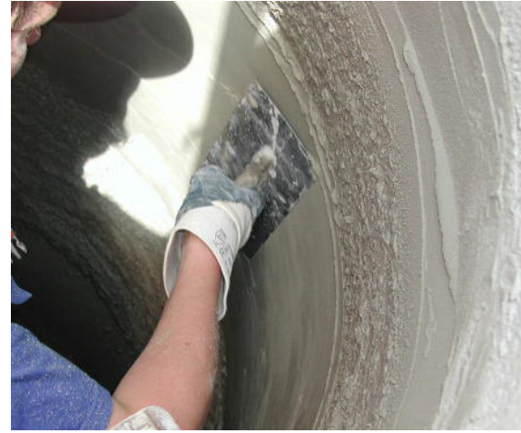
Abb. 83: Glätten einer Schichtlage bei einer Mörtelbeschichtung im Nassspritzverfahren
