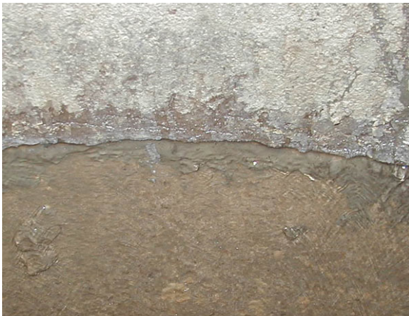
Abb. 58: Undichte Ringfuge in einem Schacht aus Betonfertigteilen
