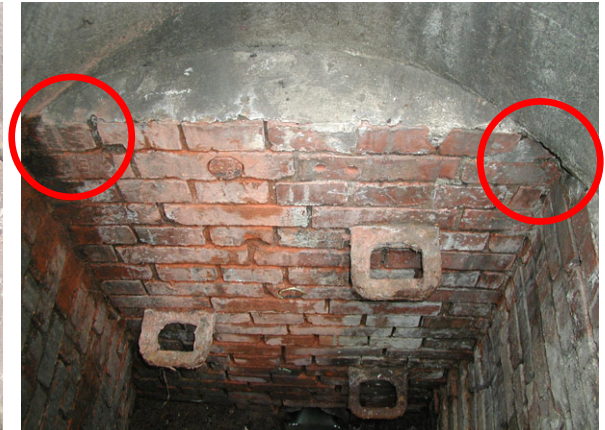
Abb. 63: Übergangsbereich rechteckiger Mauerwerksschacht / runder Konus aus Beton mit waagerechten Versprünge in der Schachtwan- dung
