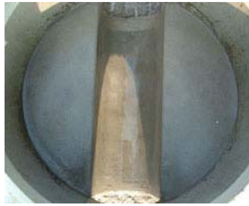
Abb. 129: Ansicht eines gereinigten Schachtelementes
