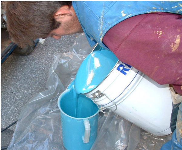
Abb. 88: Nachfüllen der Stamm-Komponente bei der Beschichtung eines Schachtes
