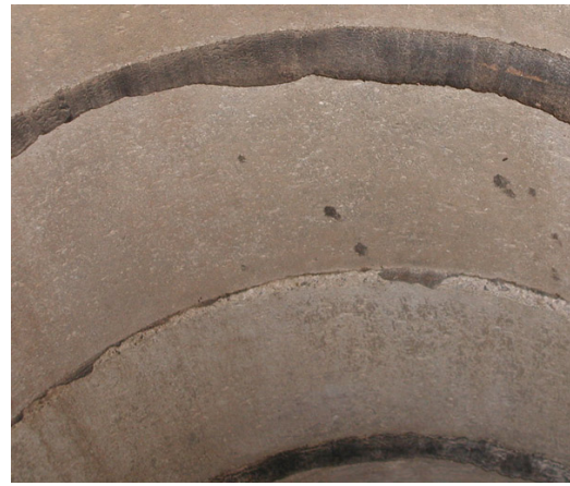
Abb. 59: Aus den Ringfugen einragende Bitumendichtmasse in einem Schacht aus Betonfertigteilen
