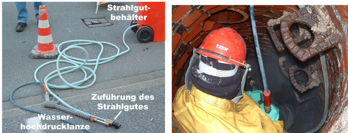
A B Abb. 146: Reinigung einer Schachtwandung mit Wasserhochdruck unter Beimischung von festem Strahlgut. A: Wasserhochdrucklanze mit Strahlgutzuführung. B: Ausführung der Reinigung in einem Schacht.
