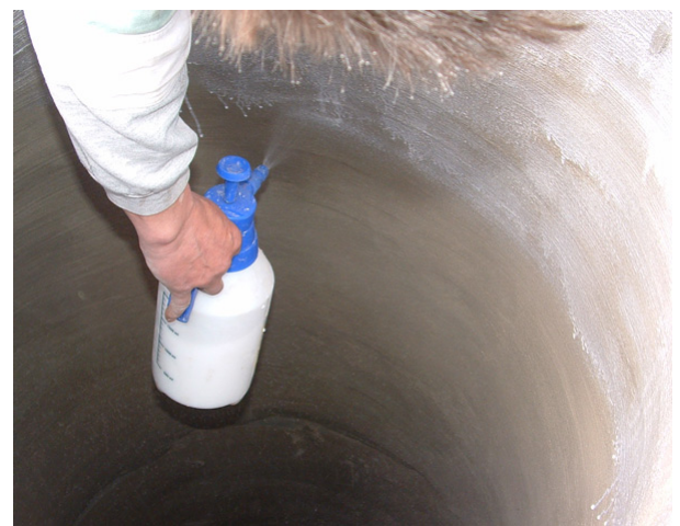
Abb. 92: Aufspritzen eines Nachbehandlungsmittels auf eine Mörtelbeschichtung
