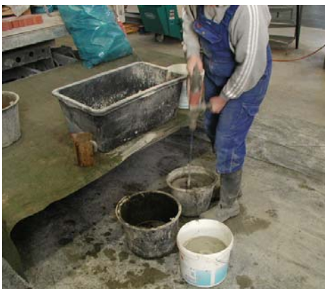
Abb. 130: Mischung des Mörtels von Hand Abb. 131: Mörtelbeschichtung im händischen Auftrag
