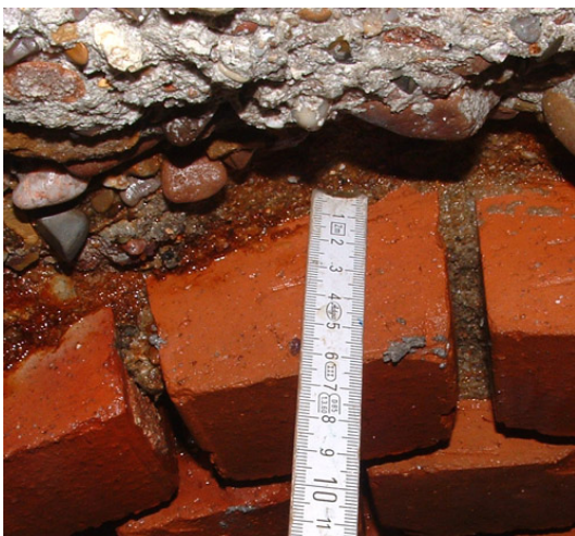
Abb. 60: Starker Abtrag durch Korrosion in einem Schacht mit Mauerwerkunterteil und aufgesetzten Betonfertigteilen
