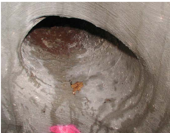
Abb. 101: Bündige und dichte Anbindung eines seitlichen Zulaufs
