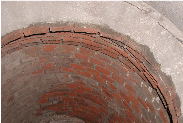
Abb. 62: Übergangsbereich Mauerwerksschacht / Konus aus Beton
