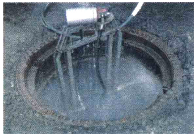
Abb. 36: Wasserhochdruckreinigung mittels rotierender Schachtreinigungsdüse [52]
