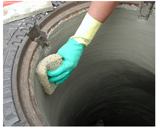
Abb. 90: Befeuchten der Mörtelbeschichtung nach Auftrag
