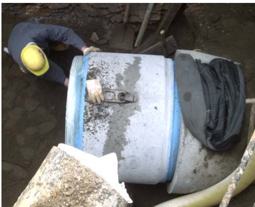
Abb. 20: Einfetten des Gelenkstückes vor dem Einbau des Schachtes (aus [26])
