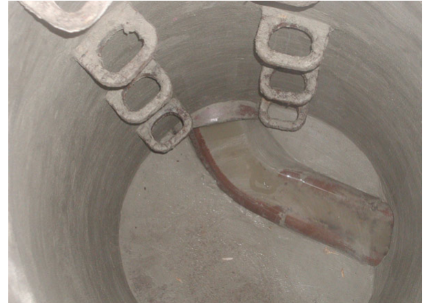
Abb. 75: Vorbeschichtung der Schachtwänden mit mineralischen Mörteln. A: Vorbeschichtung einer Mauerwerkswandung mit starker Fugenkorrosion. B: Vorbeschichtung einer korrodierten Betonwandung. C: Glätten der Oberfläche einer Vorbeschichtung. D: Komplett vorbeschichteter Mauerwerksschacht.
