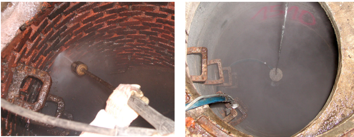
Abb. 71: Wasserhochdruckreinigung einer Schachtwandung. A: Mit Handlanze. B: Mit rotierender Reinigungsdüse.
