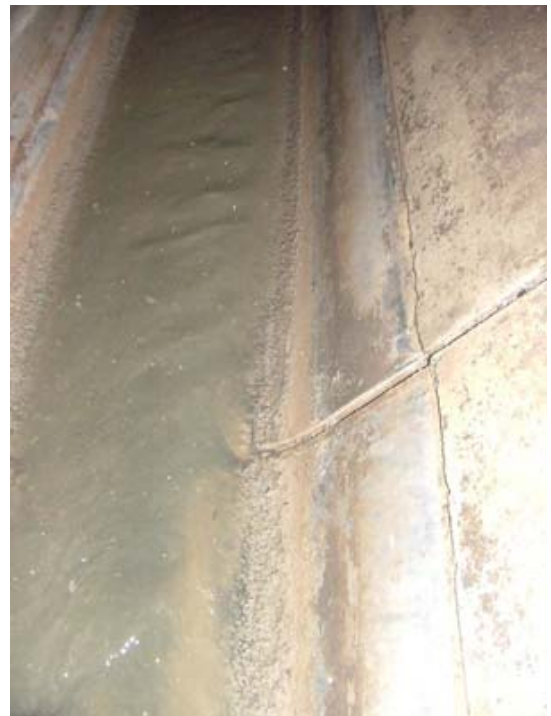
Sielhaut Wärmetauscherkanal
