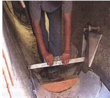
WT-Element wird präzise auf der Kanalsohle platziert
