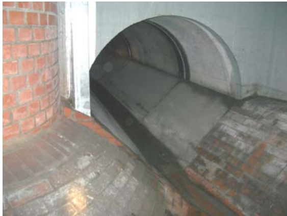
Haltungsende Betonkanal
