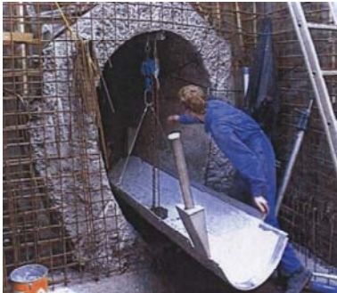
WT-Element (Gruppenendstück mit Anschlussstutzen für Vor-/Rücklauf) wird in Kanal gebracht
