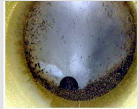
Arbeitende Düse im Rohr
