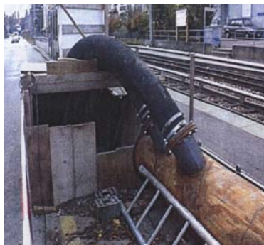
Provisorische Pumpleitung für die Umleitung des Abwassers während der Montagezeit (200 l/s)
