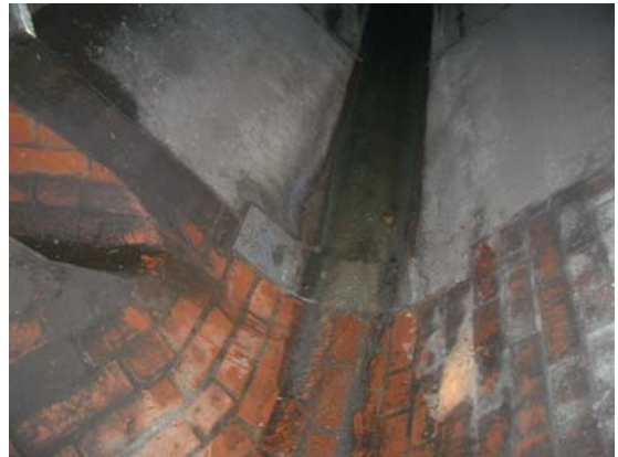
Sielhaut Wärmetauscherkanal
