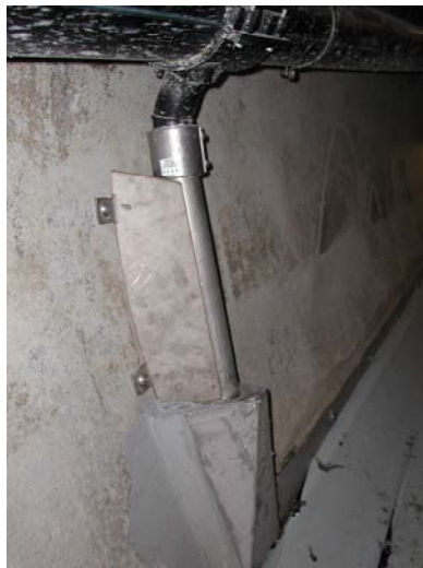
Detail Anschluss Wärmetauscher an Vor- bzw. Rücklaufleitung
