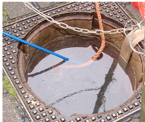
Abb. 5: Füllen des Schachtes bis zu den Auflagerungen für eine Prüfung gemäß DIN EN 1610 [15]
