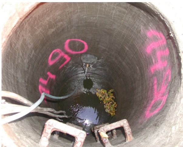
Abb. 4: Füllen des Schachtes bis 50 cm über dem Scheitel der untersten Rohreinbindung für eine Prüfung gemäß ATV-M 143, Teil 6 [14]
