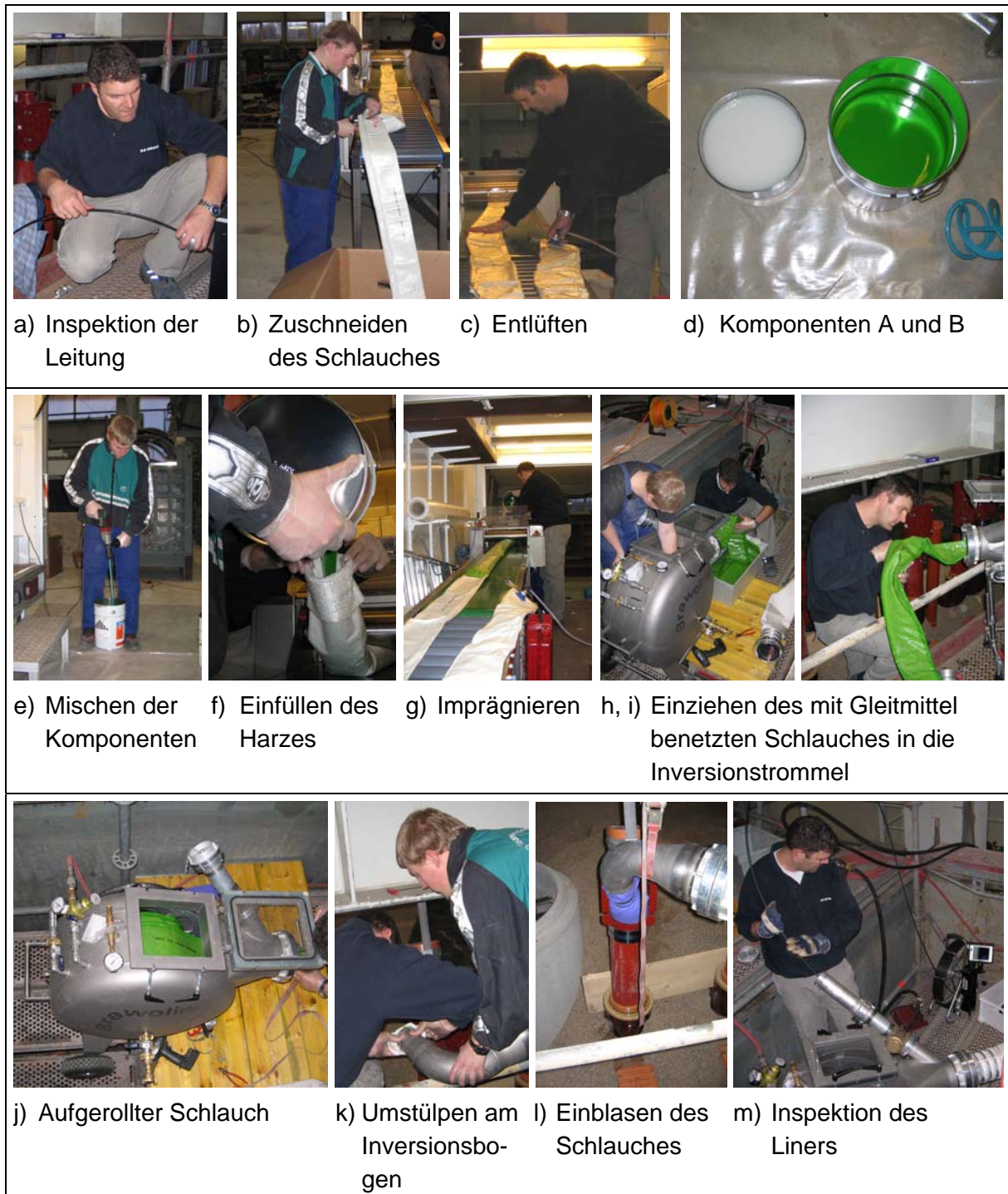
Abb. 10: Einbau des BRAWOLINER - FIX im Großversuchsstand
