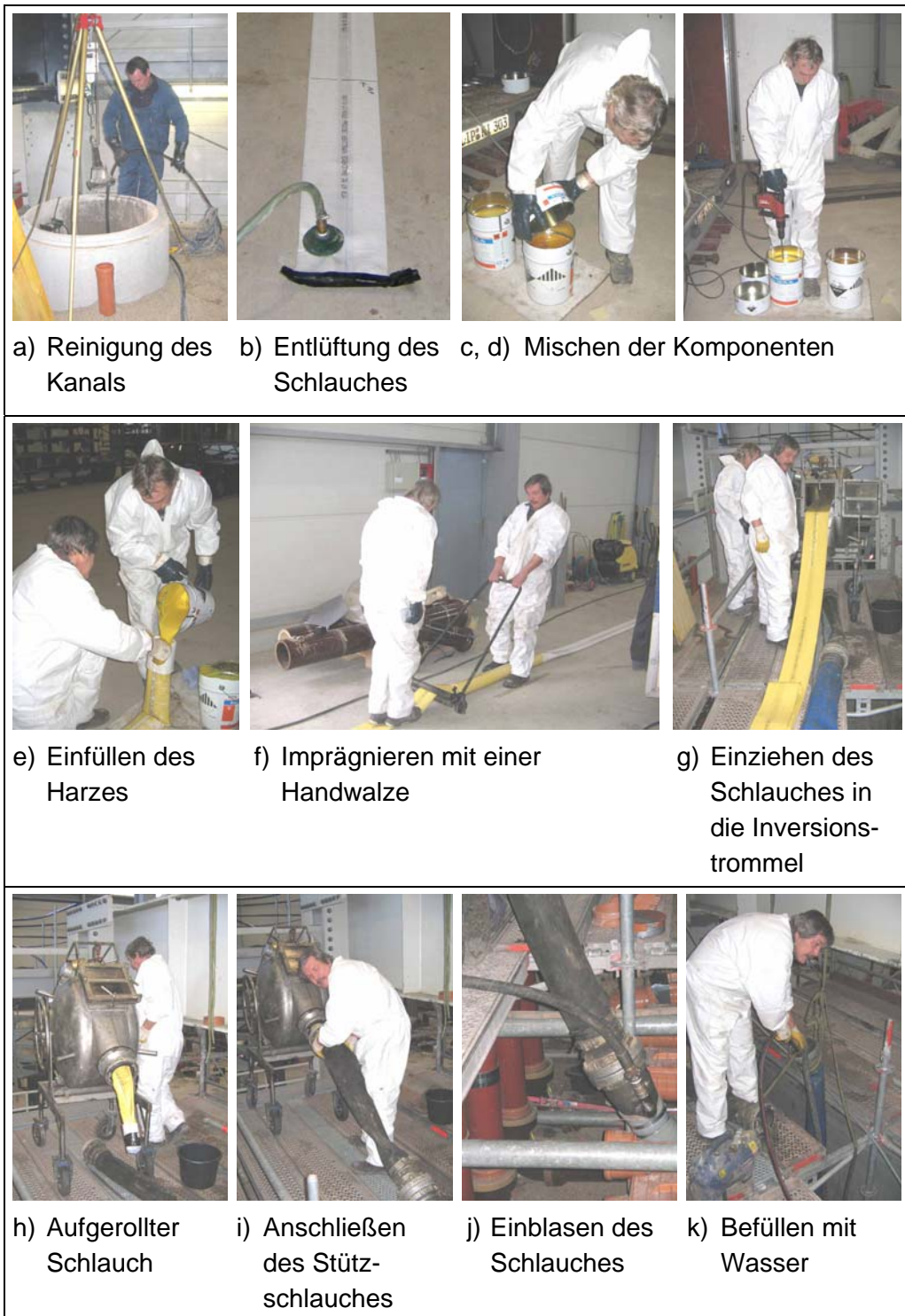
Abb. 11: Einbau des Konudur Homeliners im Großversuchsstand
