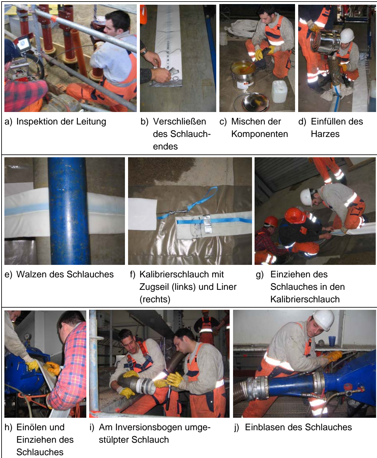
Abb. 9: Einbau des DrainPlusliners im Großversuchsstand
