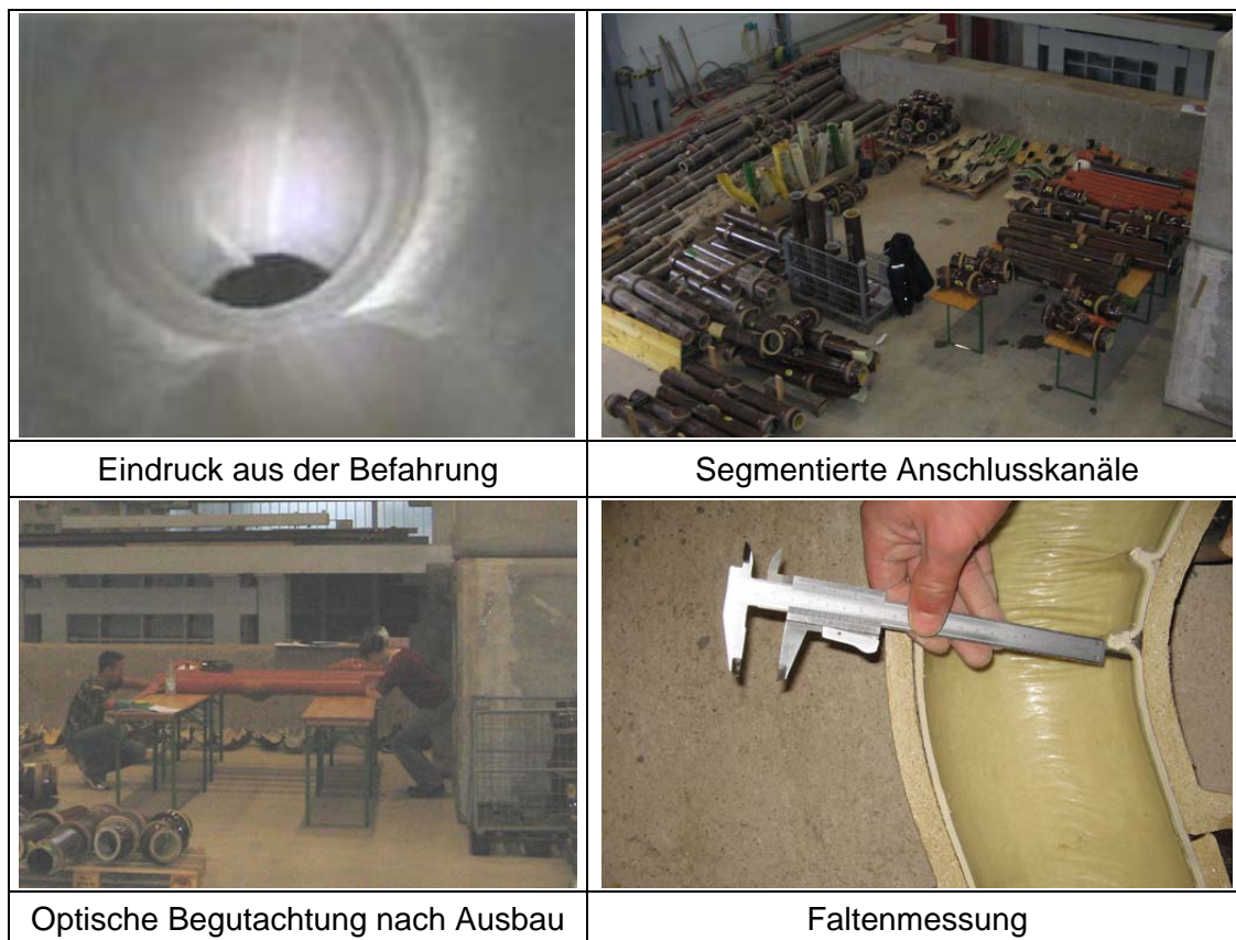
Abb. 13: Optische Inspektion der sanierten Anschlusskanäle
