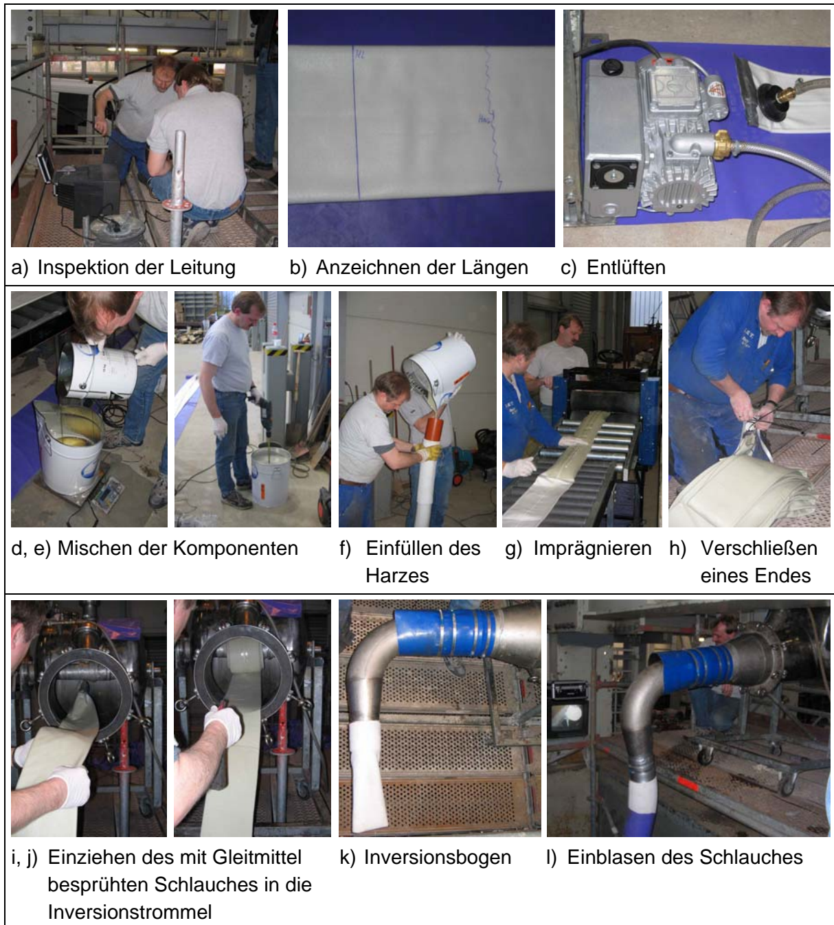
Abb. 8: Einbau des SoftLiners bzw. BendiLiners im Großversuchsstand
