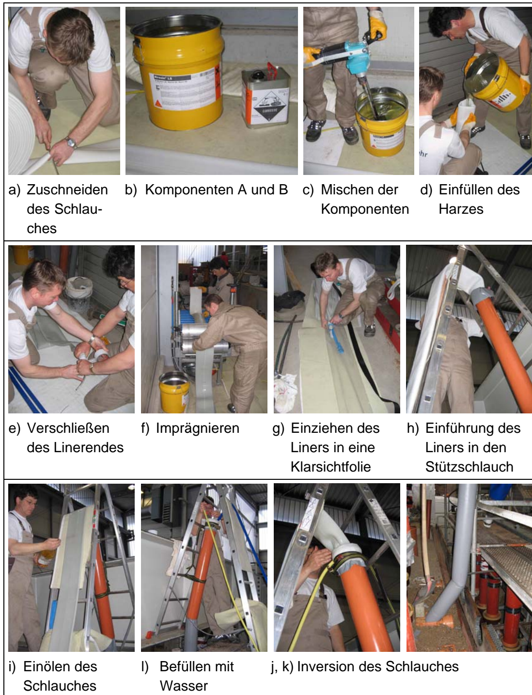
Abb. 12: Einbau des ProFlex Liners im Großversuchsstand
