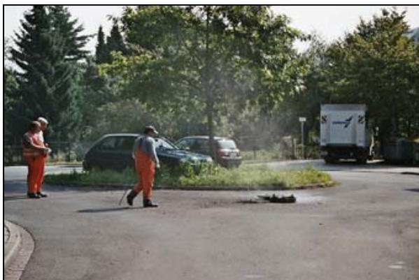
**Abbildung 6: Austretende Aerosole bei der Reinigung mit dem HD-Spülverfahren vor Ort (I)**
