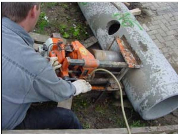
**Abbildung 3: Anbohren von Rohren mittels Anbohrarmatur zum Anbinden von Hausanschlussleitungen (I)**
