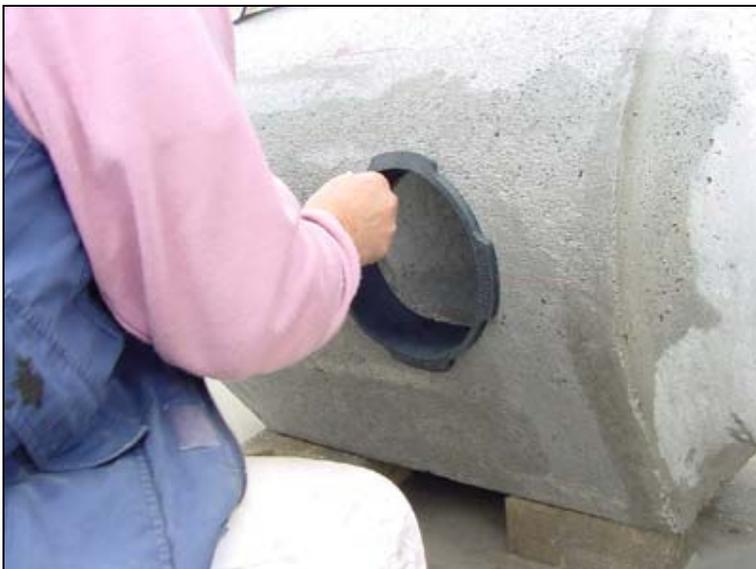
**Abbildung 4.5: Einbau der Gummidichtung eines Hausanschlussstutzens (I)**
