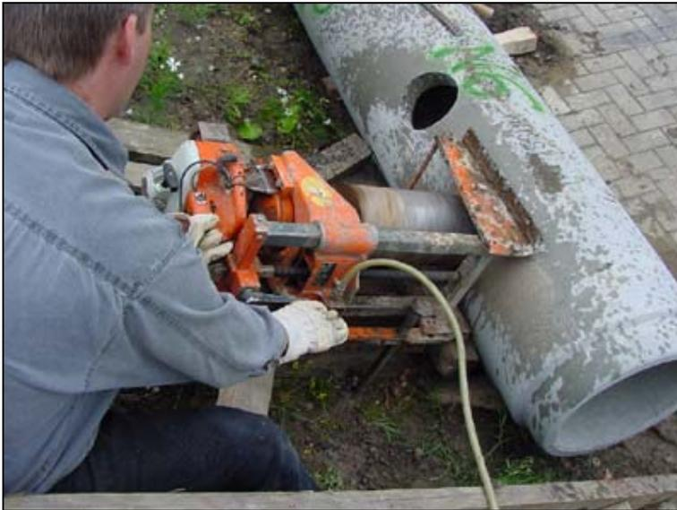
**Abbildung 4.4: Anbohren von Rohren mittels Anbohrarmatur zum Anbinden von Hausanschlussleitungen (I)**
