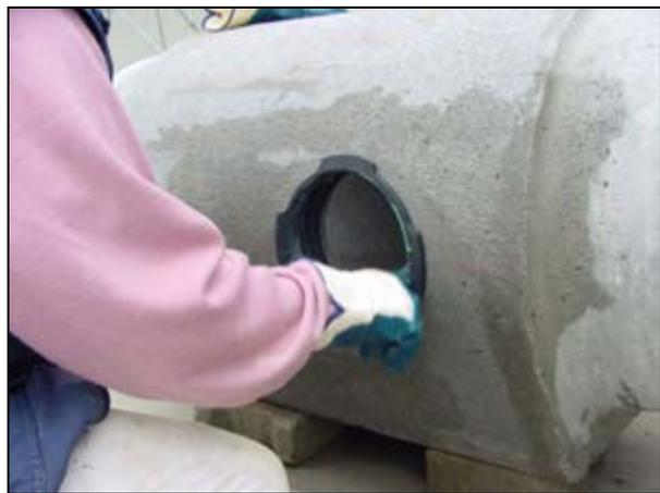
**Abbildung 4: Einbau der Gummidichtung eines Hausanschlussstutzens (I)**
