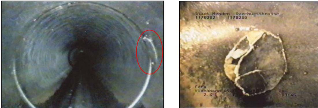
**Abbildung 5.4: Scherbenbildung an Asbestzementrohren (II)**
