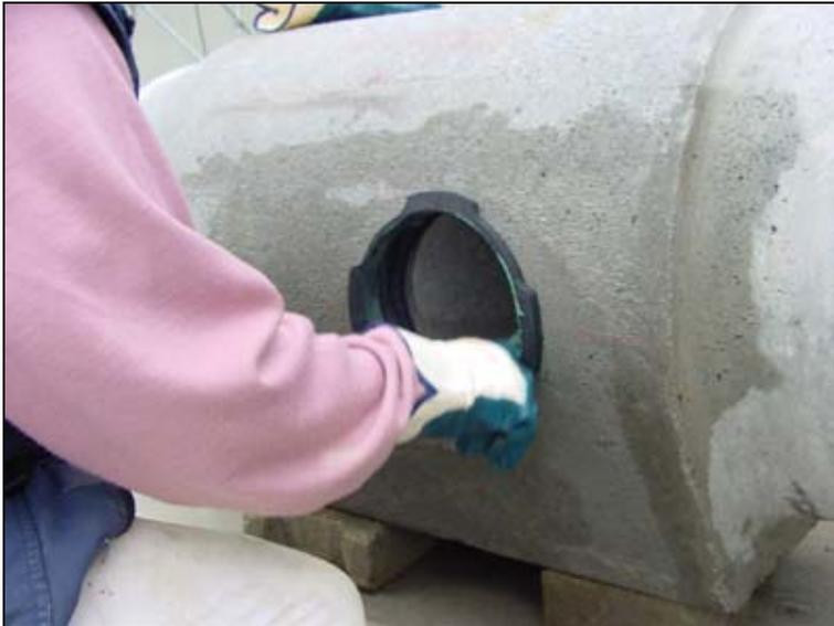
**Abbildung 4.6: Auftragen von Gleitmittel auf die Gummidichtung, in die der Stutzen eingeschoben wird (I)**
