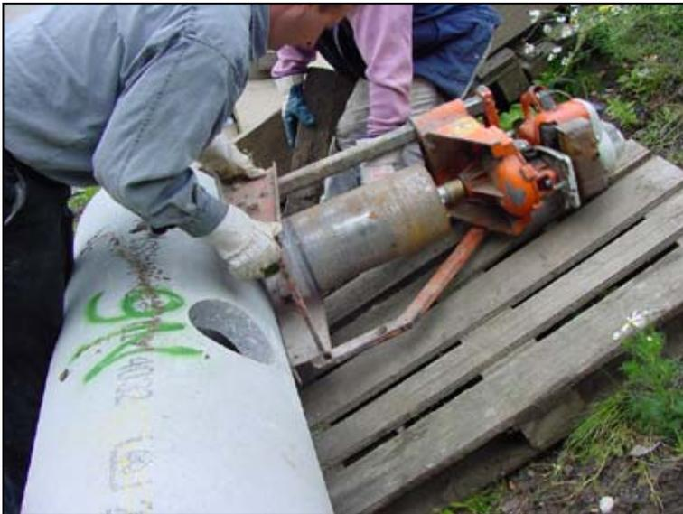
**Abbildung 4.3: Befestigung des Bohrgerätes am Rohr zur Durchführung einer Kernbohrung (I)**
