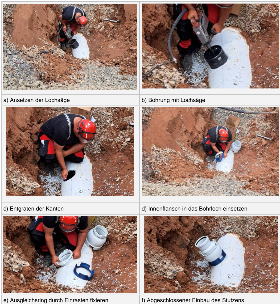
Abb. 10 Stutzeneinbau auf der Baustelle in Bodenfelde
