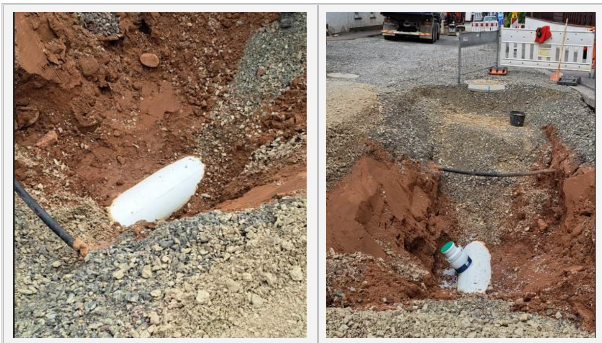
Abb. 9 Baustelle in Bodenfelde
